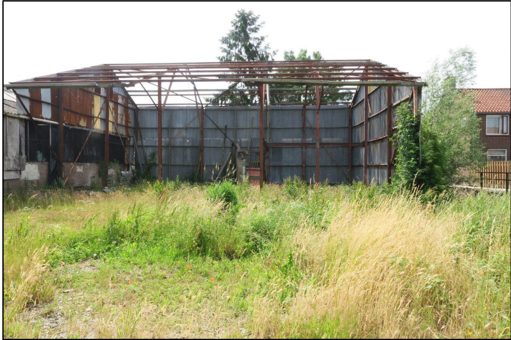
Figuur 3 De open loods bestaat uit een stalen frame en golfplaten wanden.
