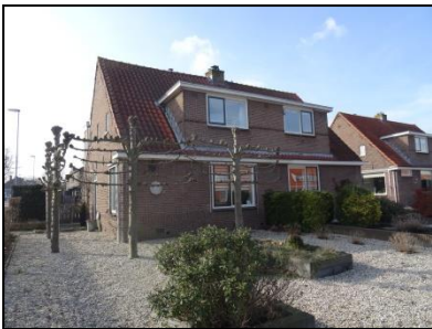
Figuur 45. Overzichtsfoto van de te renoveren woningen.
