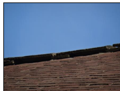
Figuur 23. Ruimte onder de kantpannen.
