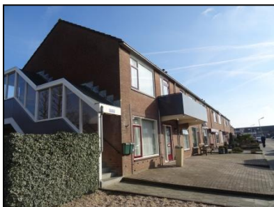
Figuur 28. Overzichtsfoto van de te renoveren woningen.
