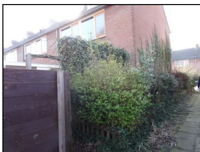
Figuur 32. Begroeiing op de gevel van een woning.
