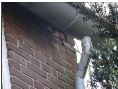
Figuur 37. Ruimte achter de dakgoot en poepstrepen, die mogelijk duiden op een gierzwaluwnestlocatie.
