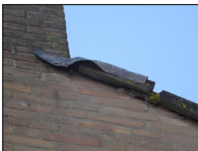
Figuur 8. Loodslab bij kantpannen kopse kant. Ruimte aanwezig onder de loodslab en kantpannen.
