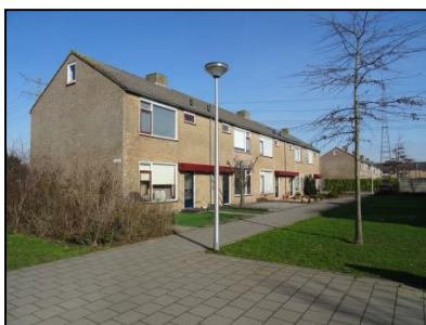
Figuur 7. Overzicht van de te renoveren woningen.
