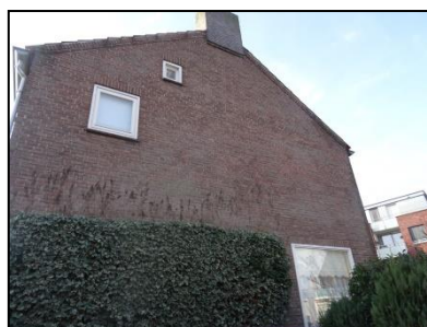
Figuur 41. Begroeiing op de gevel van een woning.
