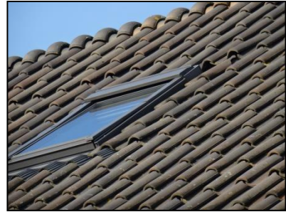
Figuur 44. Ruimte onder de dakpannen achter het dakraam.
