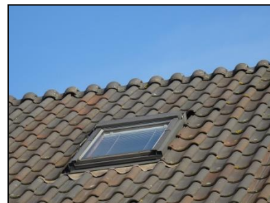
Figuur 30. Ruimte onder de dakpannen achter het dakraam.
