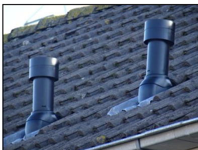
Figuur 11. Ruimte onder de dakpannen achter de ventilatiepijpen.
