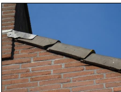
Figuur 4. Kantpannen, met ruimte onder de kantpannen en de bakstenen
