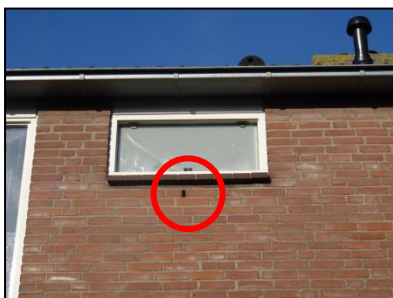
Figuur 24. Vooraanzicht van een te renoveren woning. Onder het douche-raampje is een ventilatieopening aanwezig.
