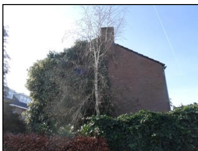
Figuur 22. Begroeiing op de gevel van een woning.
