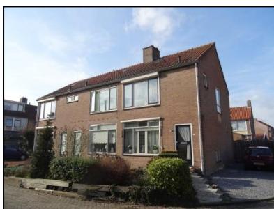
Figuur 34. Overzichtsfoto van de te renoveren woningen.
