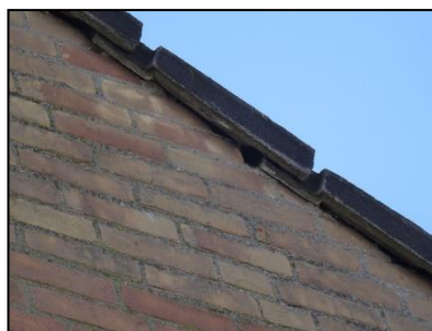
Figuur 9. Ruimte onder kantpannen en in bakstenen muur.
