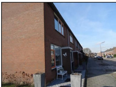
Figuur 1. Zijaanzicht te renoveren woningen op de projectlocatie.
