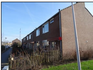
Figuur 16. Overzichtsfoto van de te renoveren woningen.
