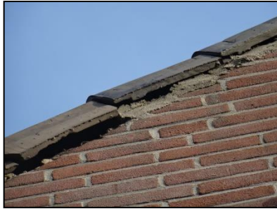
Figuur 43. Ruimte onder de kantpannen.
