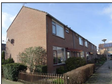
Figuur 26. Overzichtsfoto van de te renoveren woningen.
