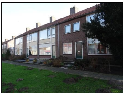
Figuur 36. Overzichtsfoto van de te renoveren woningen.
