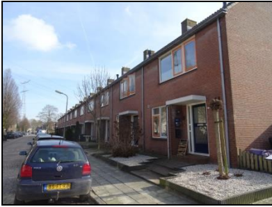
Figuur 42. Overzichtsfoto van de te renoveren woningen.
