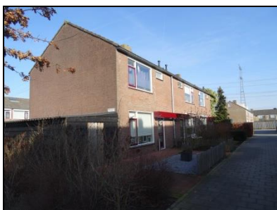
Figuur 21. Overzichtsfoto van de te renoveren woningen.
