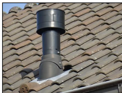
Figuur 33. Ruimte onder de dakpannen achter de ventilatiepijpen.
