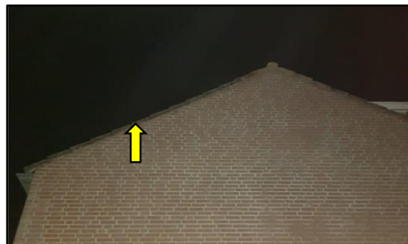
Figuur 15. Paarverblijf van één ruige dwergvleermuis, Mercuriusstraat nr. 15. Het verblijf is aanwezig onder de 6 e kantpan van de linkerzijde.
