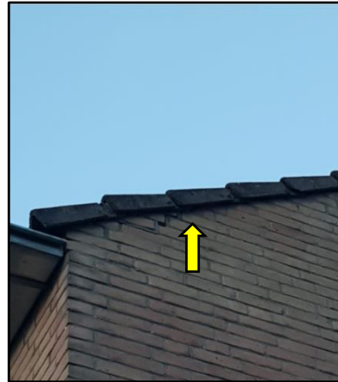
Figuur 7. Zomerverblijf van één gewone dwergvleermuis, Neptunusstraat nr. 30. Het verblijf is aanwezig onder de gevelpannen (linkerzijde) van de kopsekant van de woning.
