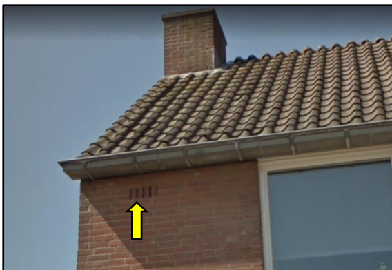
Figuur 14. Paarverblijf van één ruige dwergvleermuis, Marslaan nr. 1. Het verblijf is aanwezig in één van de ventilatiegaten (voorzijde), in de spouwmuur.
