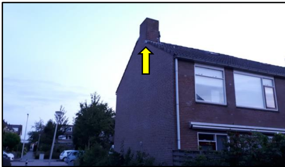
Figuur 8. Zomerverblijf van één laatvlieger, Jupiterstraat nr. 18. Het verblijf is aanwezig onder de gevelpannen (linkerzijde) van de kopgevel
