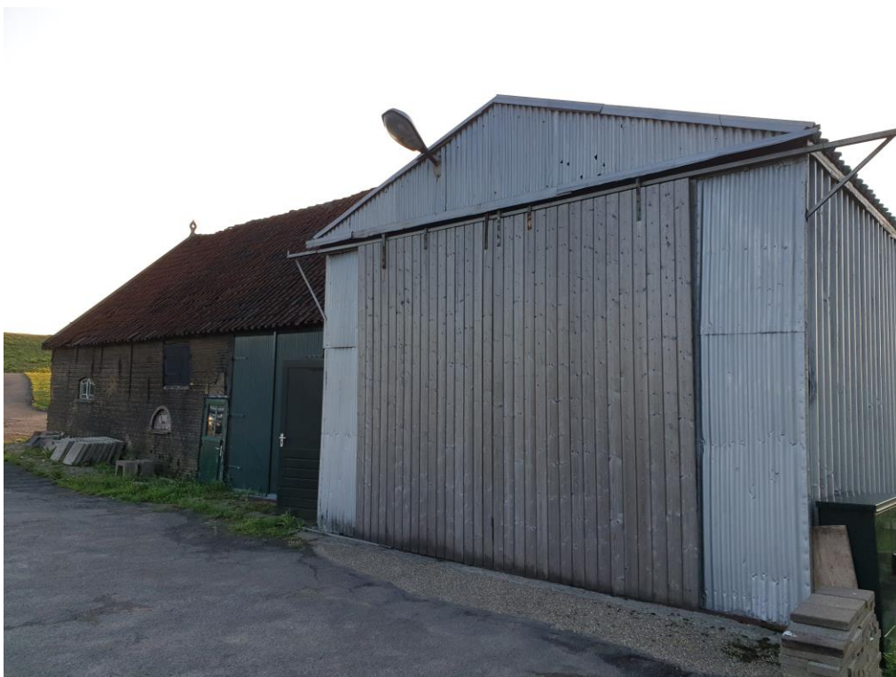
Figuur 2 De tweede schuur is gemaakt van metalen golfplaten en een houten rails-deur, verder geen isolatie.
