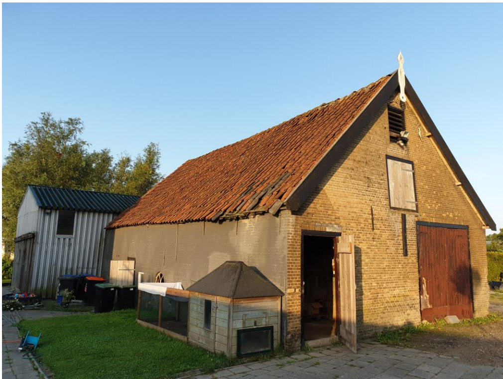
Figuur 1 De planlocatie is gelegen aan de Lekdijk 34 te Nieuw-Lekkerland en bestaat uit een gemetselde muur zonder spouw met een zadeldak met dakpannen.
