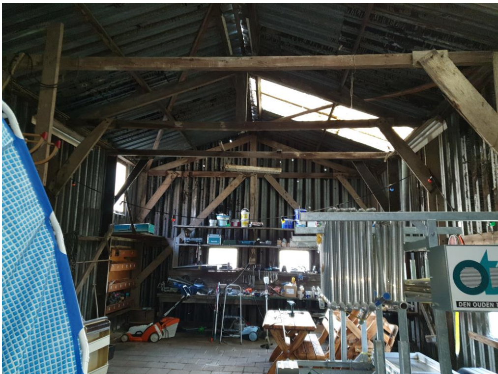
Figuur 4 De tweede schuur op de planlocatie met duidelijke enkele laag metalen golfplaten als dak en als muur.
