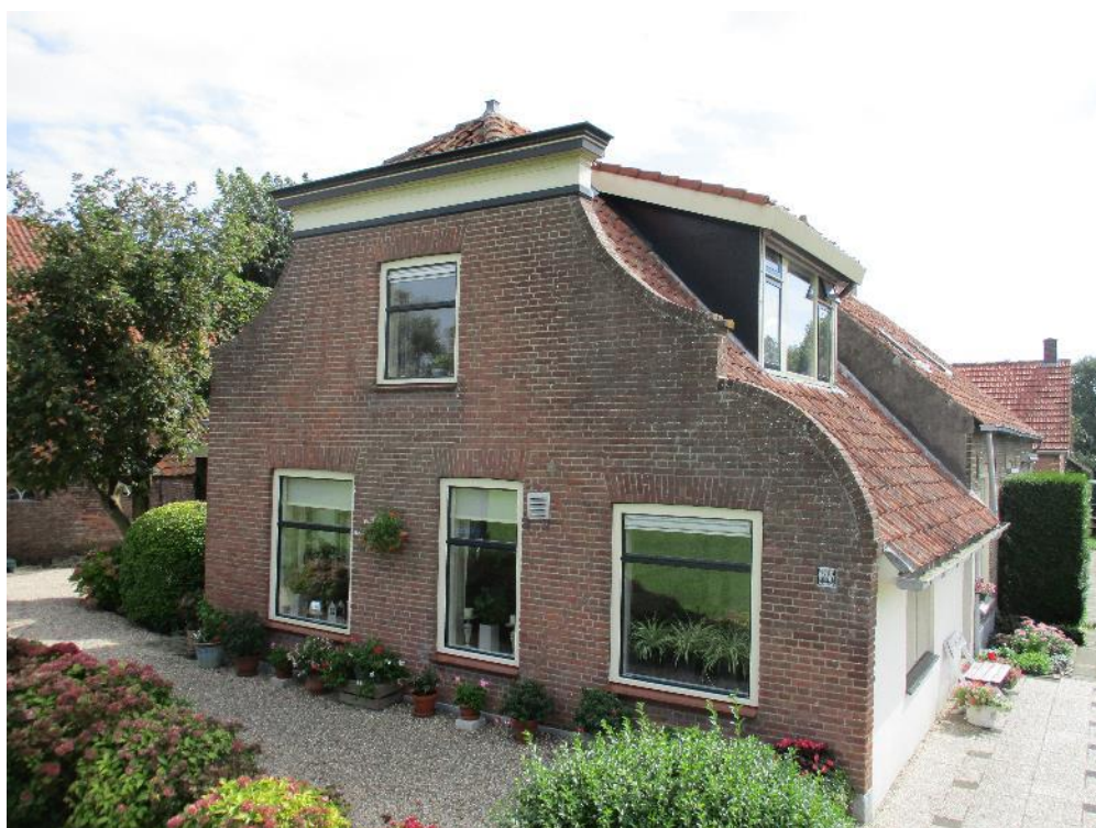
Figuur 2 De woning bevat geen openingen of kieren die gebruikt zouden kunnen worden als nestlocaties of verblijfplaatsen van vleermuizen. De aanwezigheid van huismussen kan echter niet uitgesloten worden.
