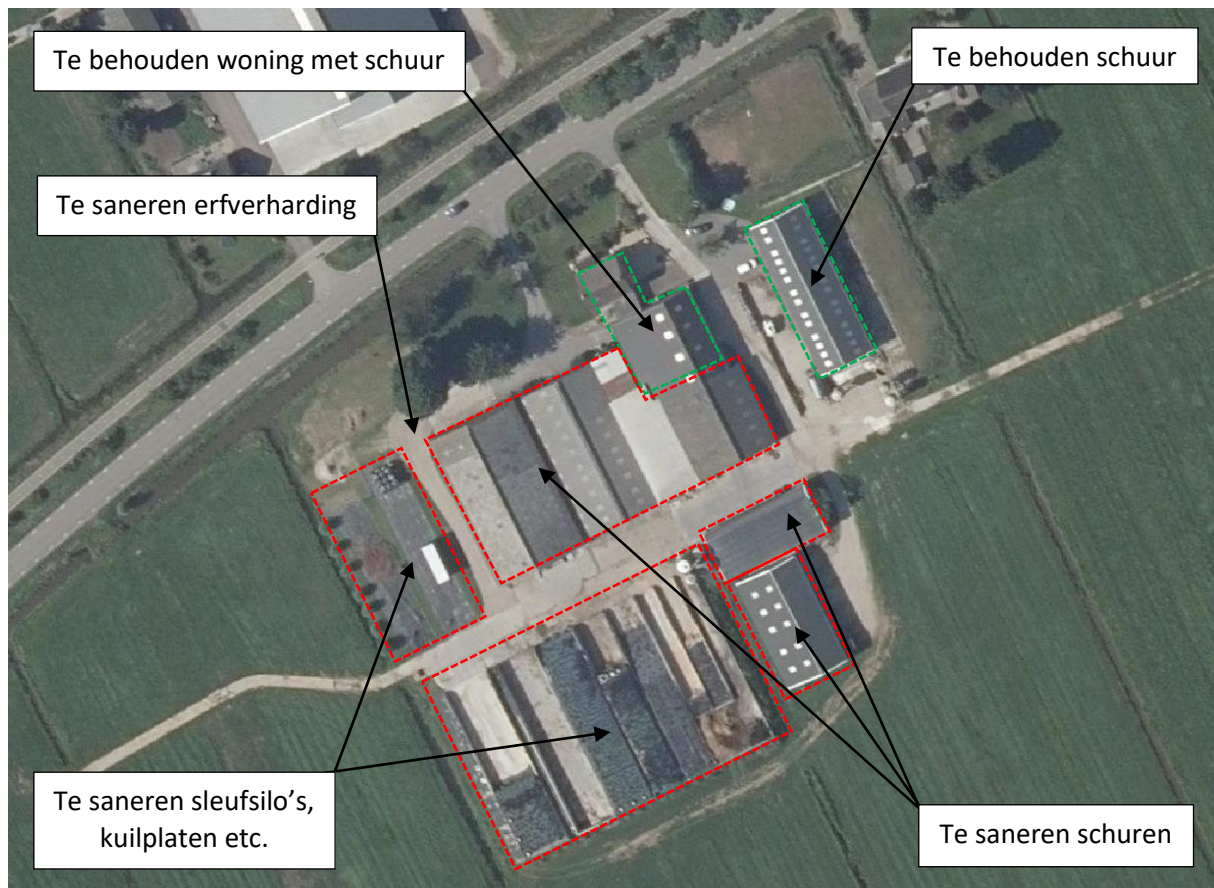
Afbeelding 15: Indicatie te slopen/saneren bebouwing en verharding
