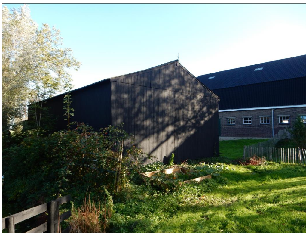
Figuur 2 De achterzijde van de kapschuur (links) en de woning (rechts).
