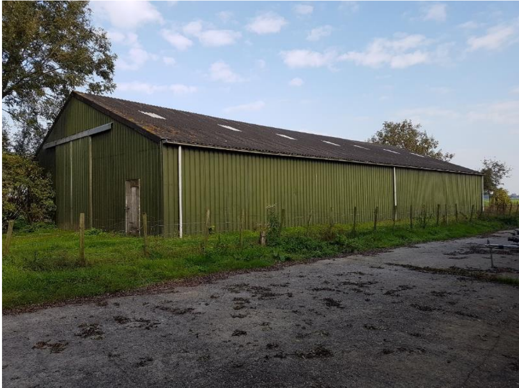
Figuur 9 De te saneren wagenloods en de betonnen bestrating aan de oostzijde van het plangebied.
