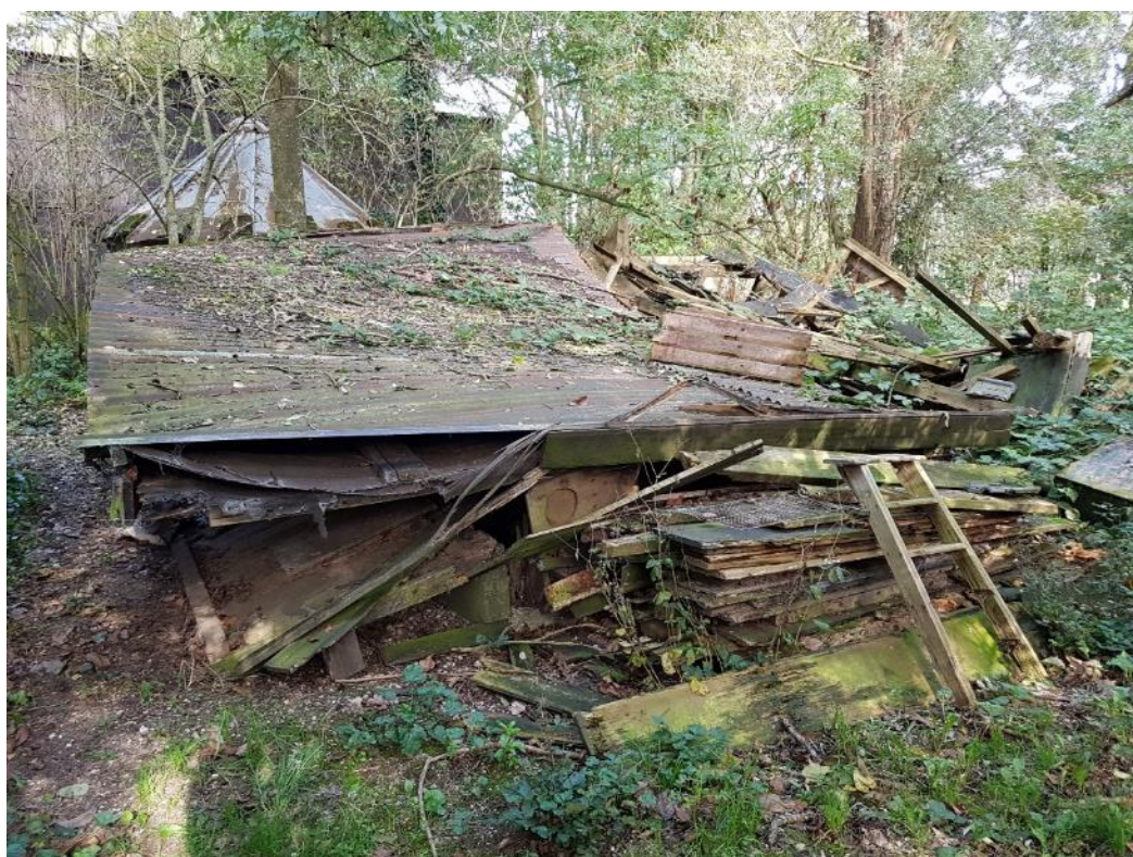
Figuur 4 Ingestorte schuur, mestsilo (linksboven) en braamstruweel (rechts) achter de voormalige bedrijfswoning.
