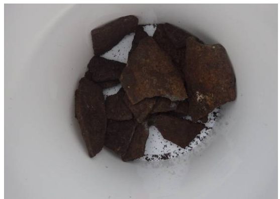
Foto 8: asbestverdacht plaatmateriaal SL51
