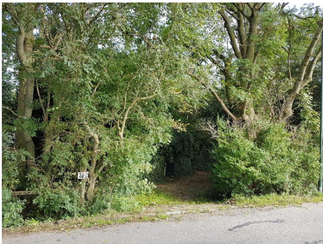
Figuur 2 Oprit en de vervallen bedrijfswoning (midden foto) ter hoogte van Grotewaard 34 te Noordeloos.
