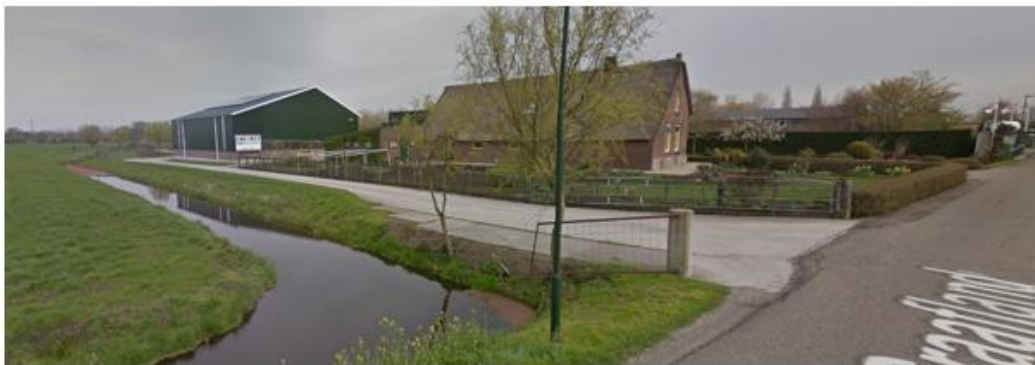
Zicht vanaf de weg (richting het oosten)
