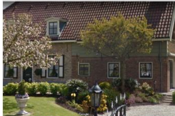
Combinatie metselwerk en potdeksel
