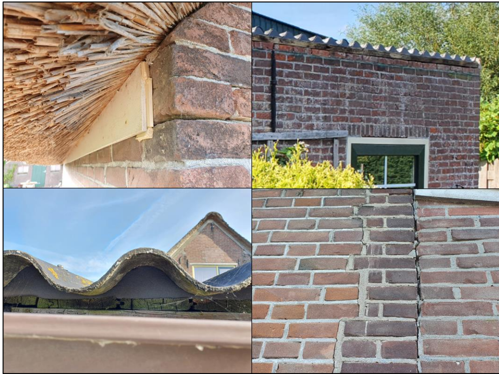
Figuur 4 De bebouwing is op plaatsen waar mogelijke gaten/kieren ontstaat welke toegang tot achterliggende ruimten kunnen bieden afgedicht door houten latten of schuimrubber randen. De woning bevat enkele haarscheuren waar specie ontbreekt, deze scheuren zijn echter te smal om toegang te bieden voor vleermuizen.
