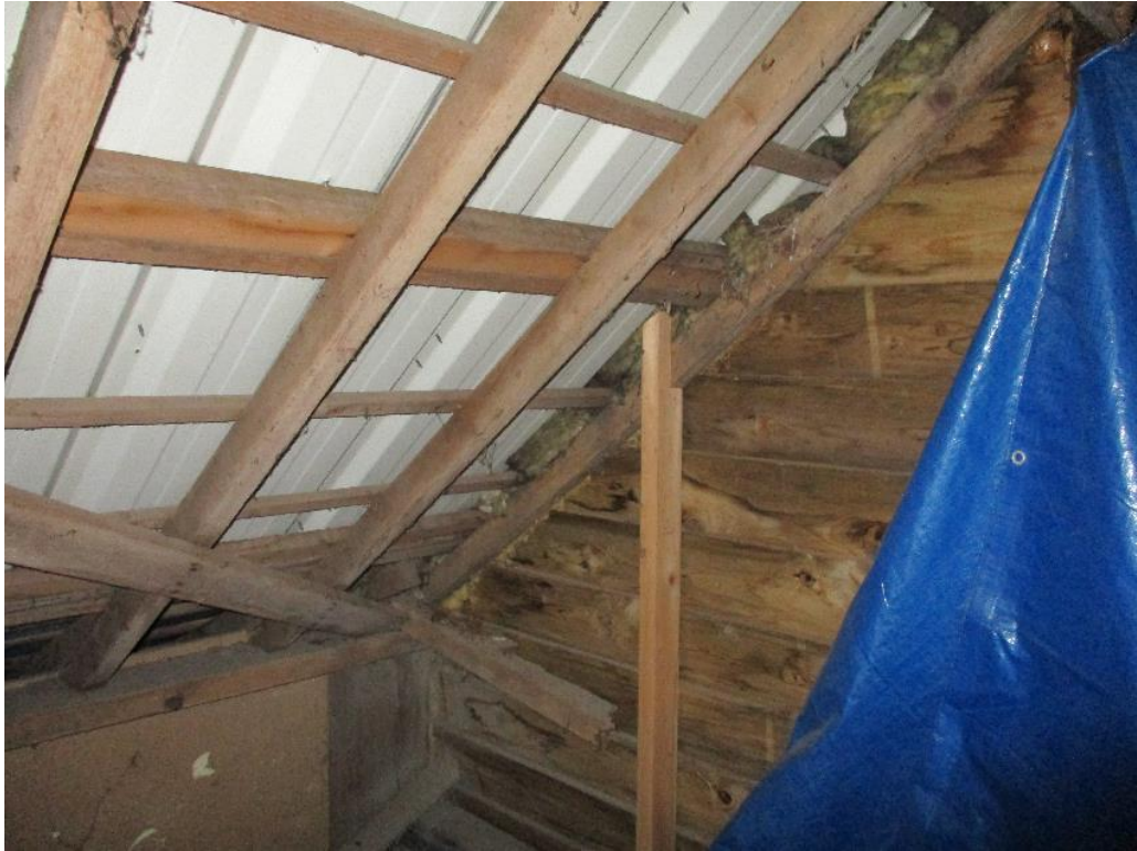
Figuur 3 Het zadeldak bestaat uit golfplaten en is volledig afgedicht en niet geïsoleerd.
