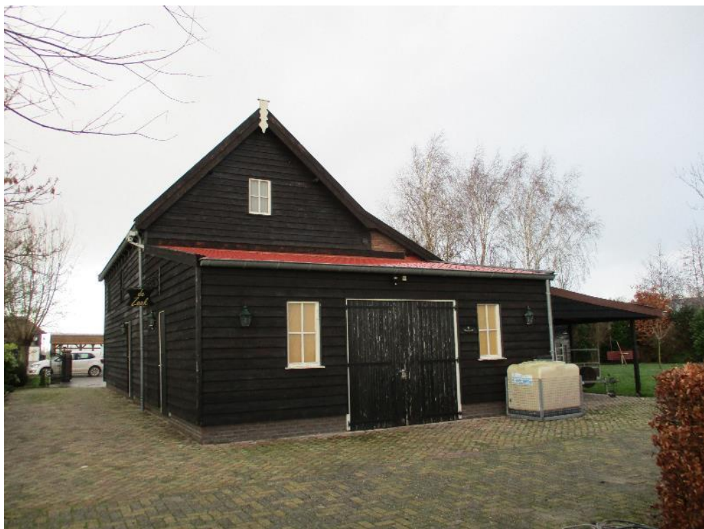
Figuur 2 Achterzijde van de schuur
