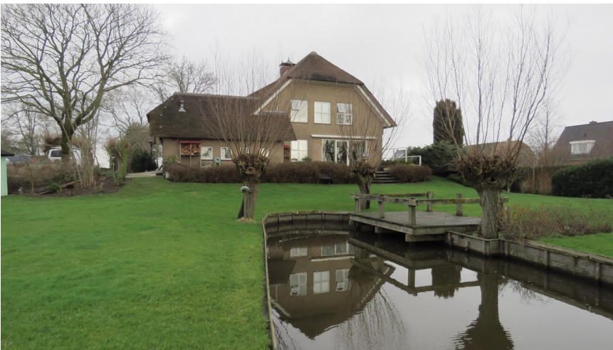
Afbeelding 4: Zicht op het woonhuis, kijkrichting noord
