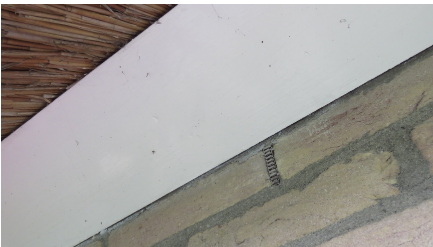
Afbeelding 11: Stootvoegen zijn ontoegankelijk door bijenbekjes en tussen de gevel en het rieten dak zijn geen geschikte kieren aanwezig.
