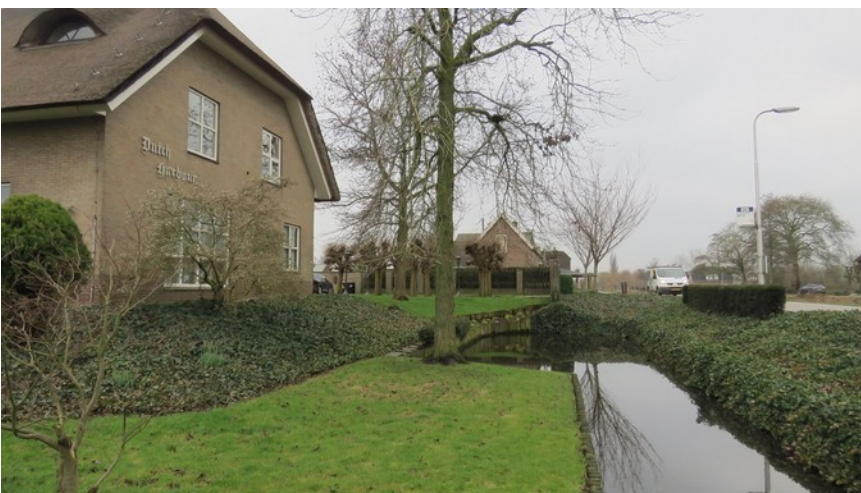
Afbeelding 5: Zicht op de straatzijde van het perceel.
