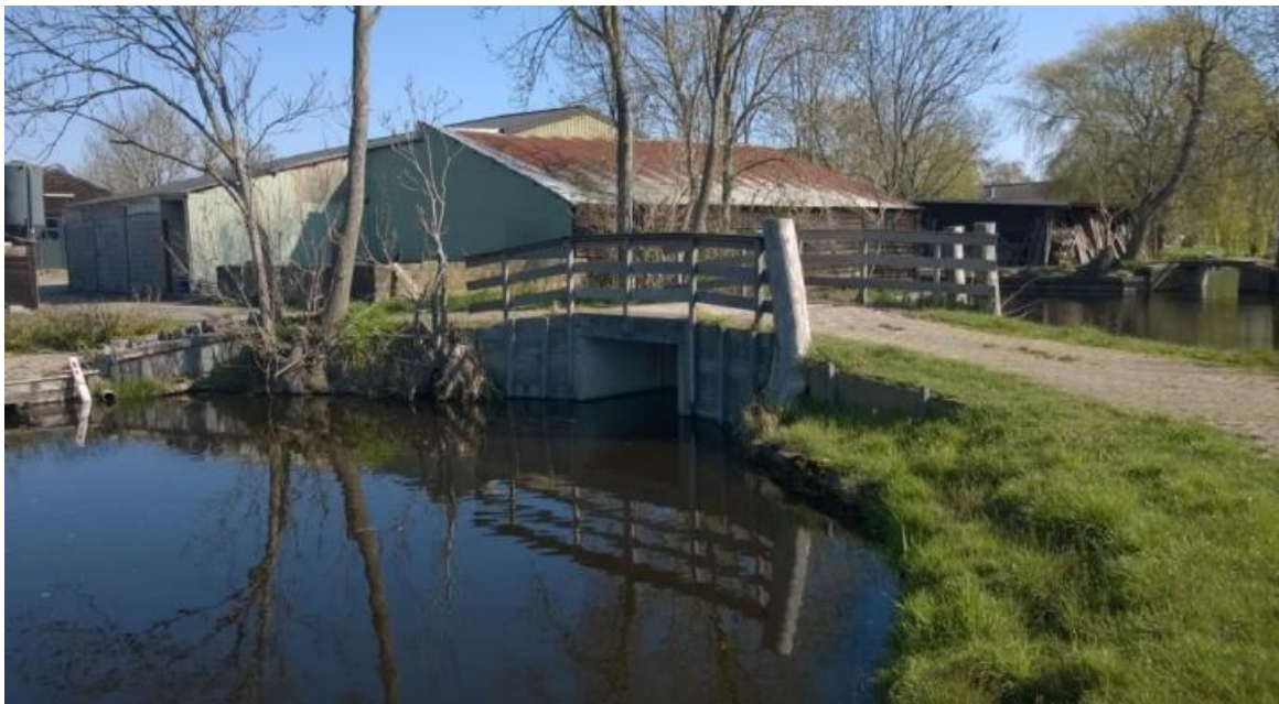
Afbeelding 6: Aanzicht vanaf de wetering (te slopen schuren)
