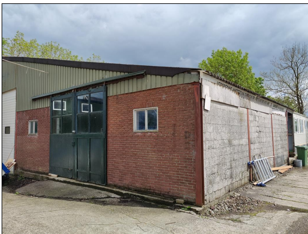
Figuur 4 De voormalige agrarische schuur vanaf de buitenzijde gezien.
