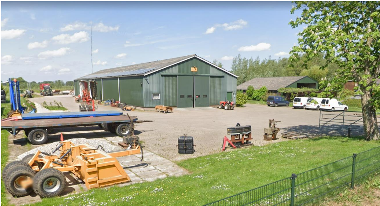
Afbeelding 7: Zicht op de west- en voorgevel van de loods
