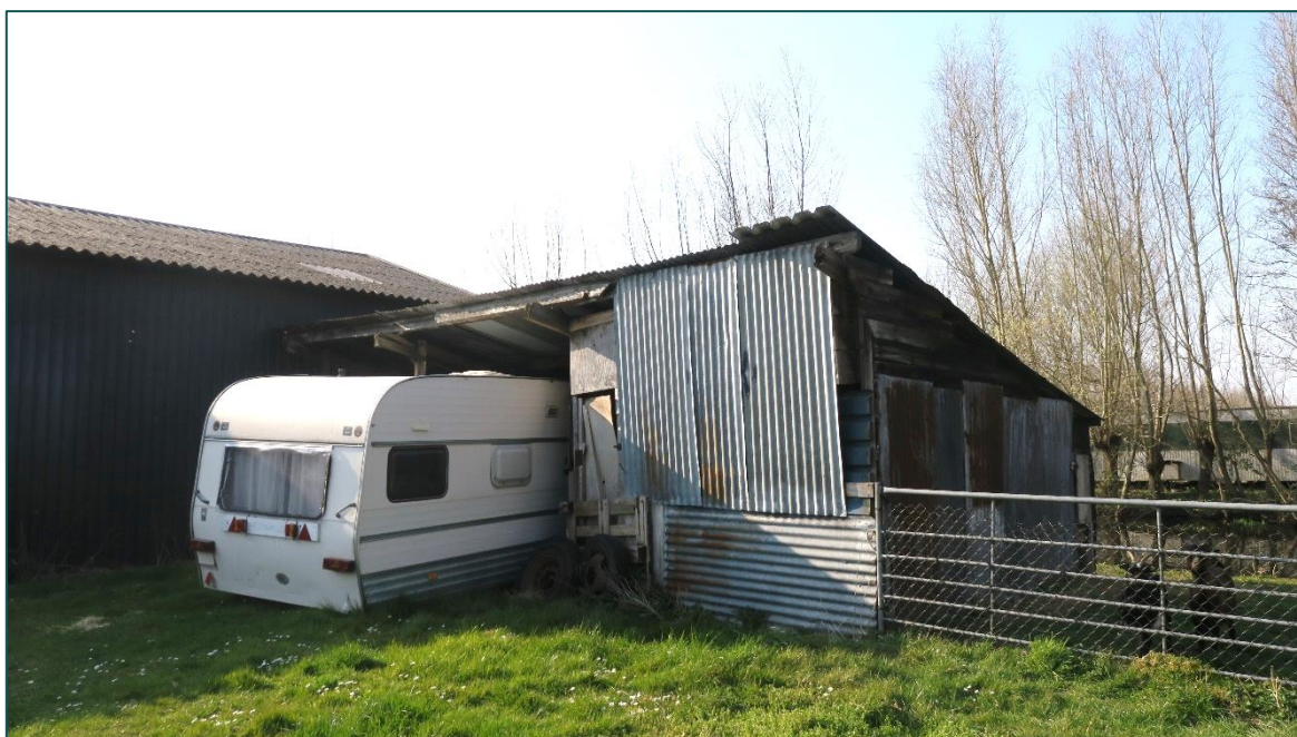
Figuur 2 De half open overkapping (2) welke binnen de beoogde ruimtelijke ingreep gesloopt zal worden.
