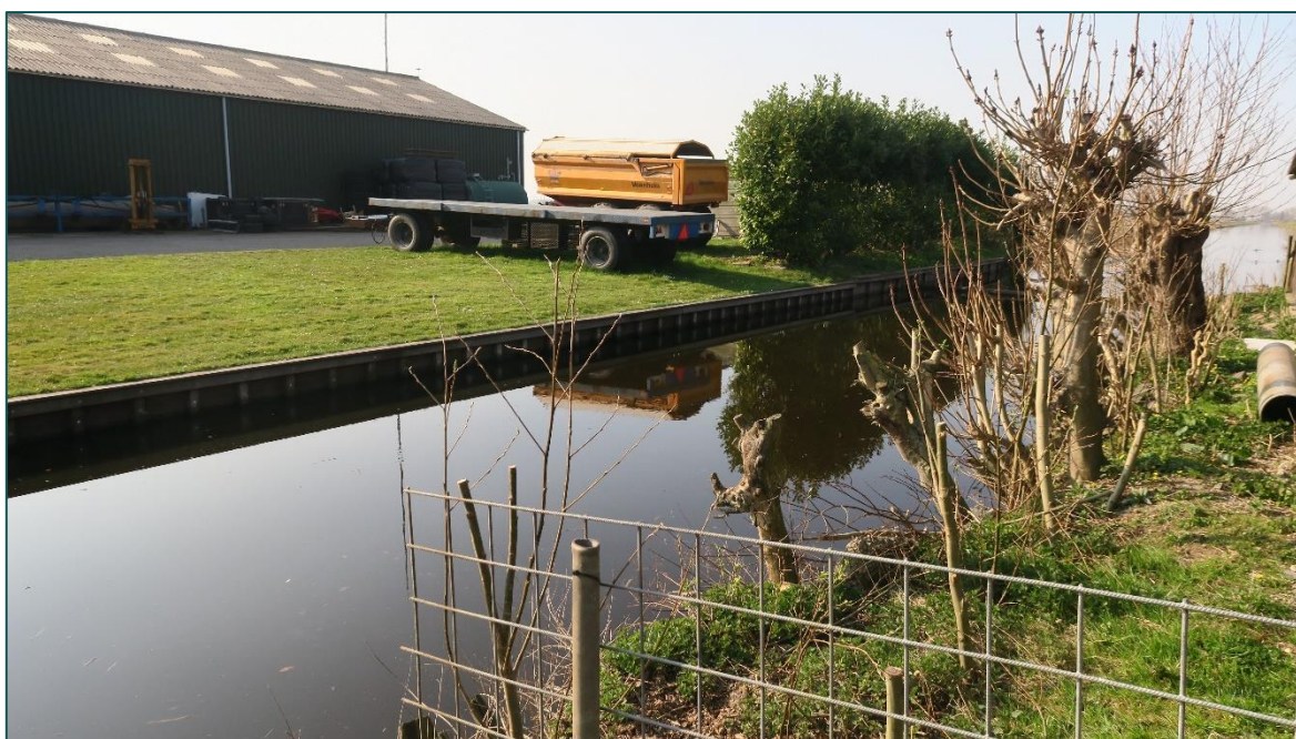
Figuur 4 In het midden van de planlocatie bevindt zich een watergang met beschoeide oevers. Aan de overzijde van het water bevindt zich de loods en de locatie waar de uitbreiding gerealiseerd zal worden.
