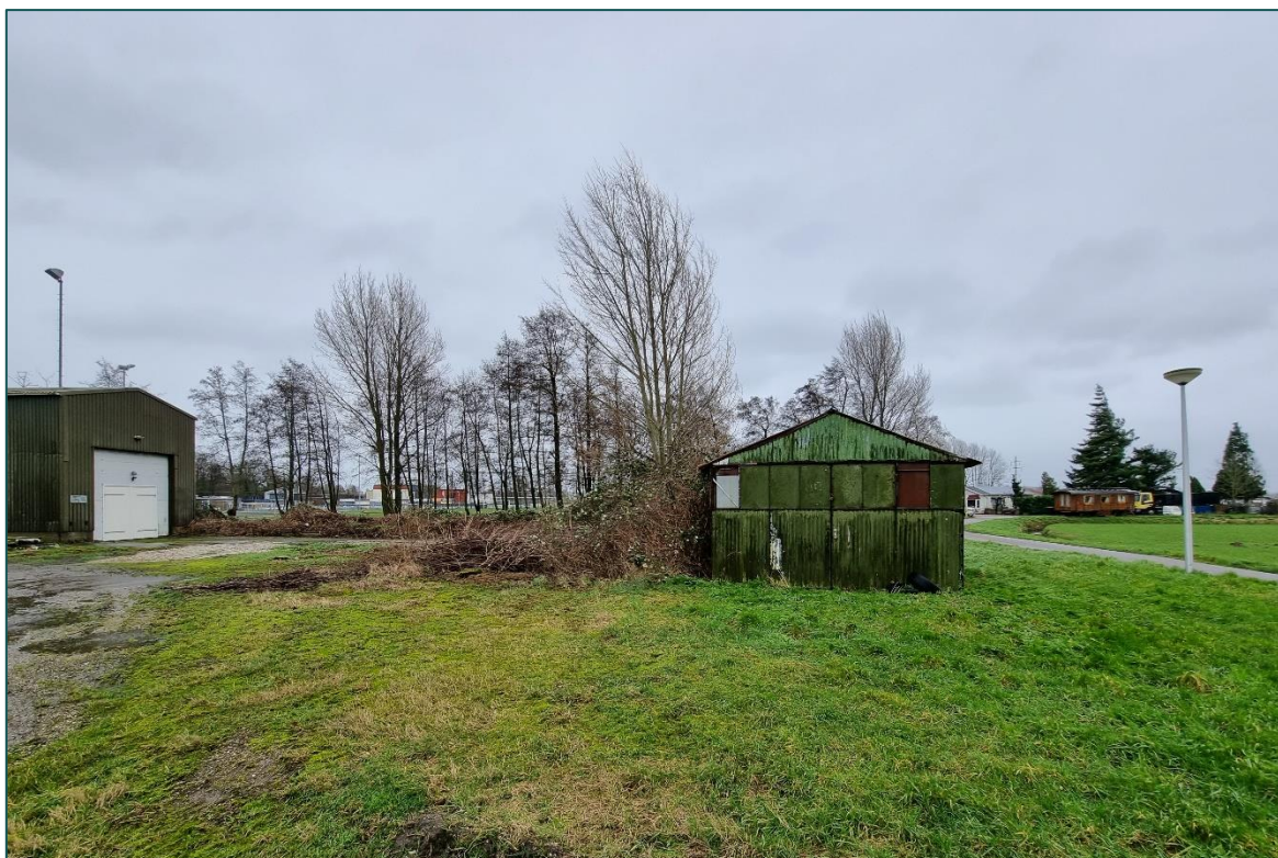
Figuur 2 De te saneren bebouwing bestaat uit een loods (links) en een schuur (midden) opgetrokken uit damwandgevels en golfplaten zadeldak.
