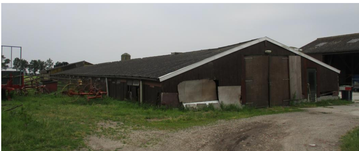
Afbeelding 8: Te saneren varkensstal Bergstoep 26 Streefkerk
