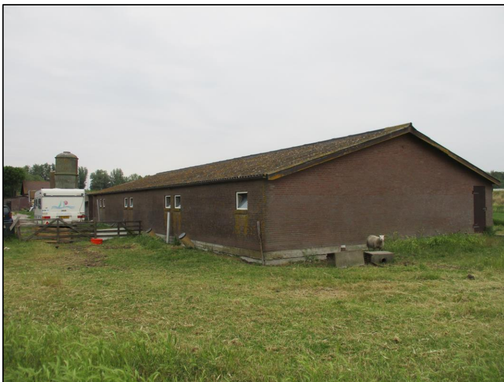
Figuur 2 Het aanzicht vanuit het zuiden op het achterste deel van het gebouw..
