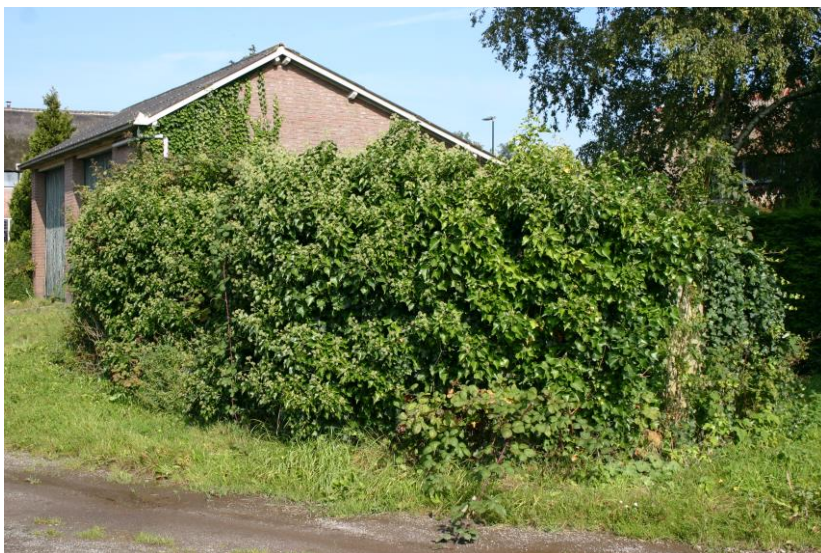
Figuur 3. De met klimop overwoekerde betonnen silo's.
