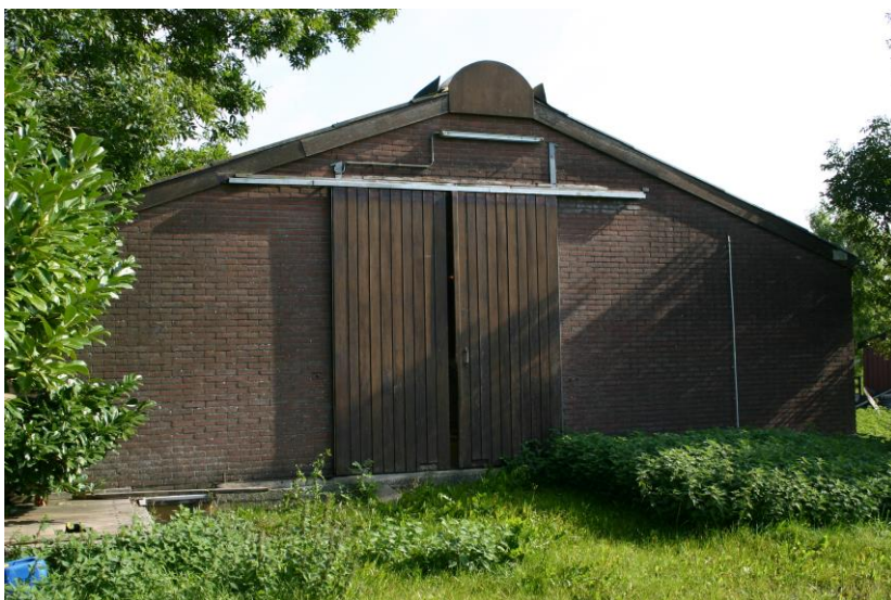
Figuur 4. De voormalige jongveestal.
