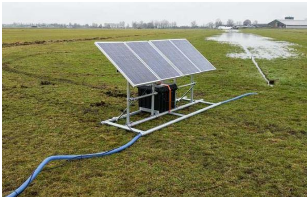
Figuur 4.3 Een plasdraspomp is een op zonnepanelen aangedreven pompsysteem waarbij slootwater wordt overgeheveld naar een greppel of greppelstructuur op een akker- of weideperceel (bron afbeelding: www.collectief-av.nl ).
