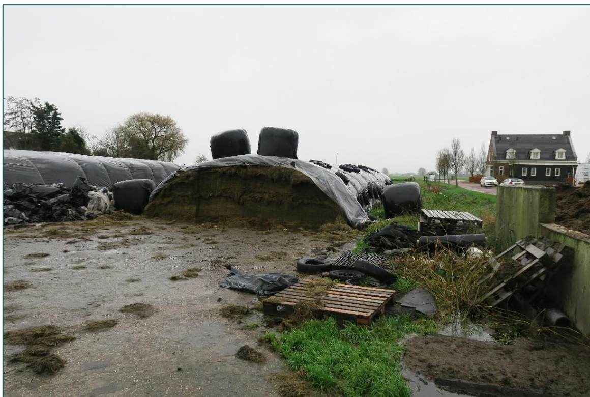
Figuur 3 Op de planlocatie zijn enkele voerkuilen aanwezig.
