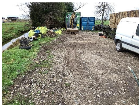
Foto F6: puinpad met containers bij woning nummer 50
