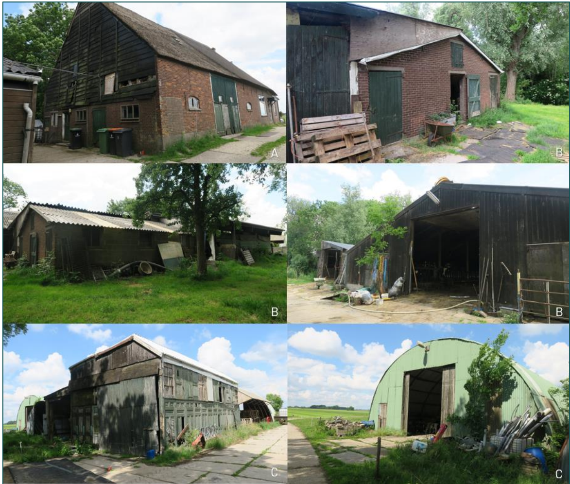
Figuur 1.3 Fotografische indruk van de bebouwing op de planlocatie. Gebouw A blijft behouden. De gebouwen B en C zullen worden gesloopt.
