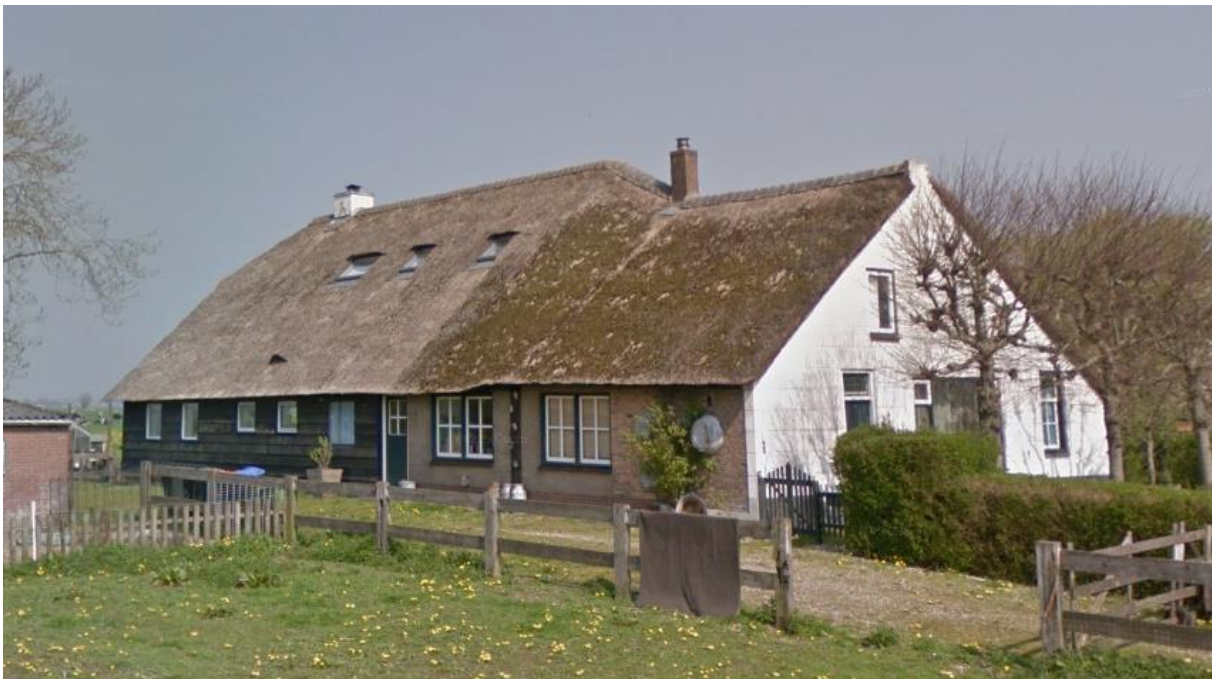
Afbeelding 5: Boerderij Brandwixsedijk 26 te Brandwijk
