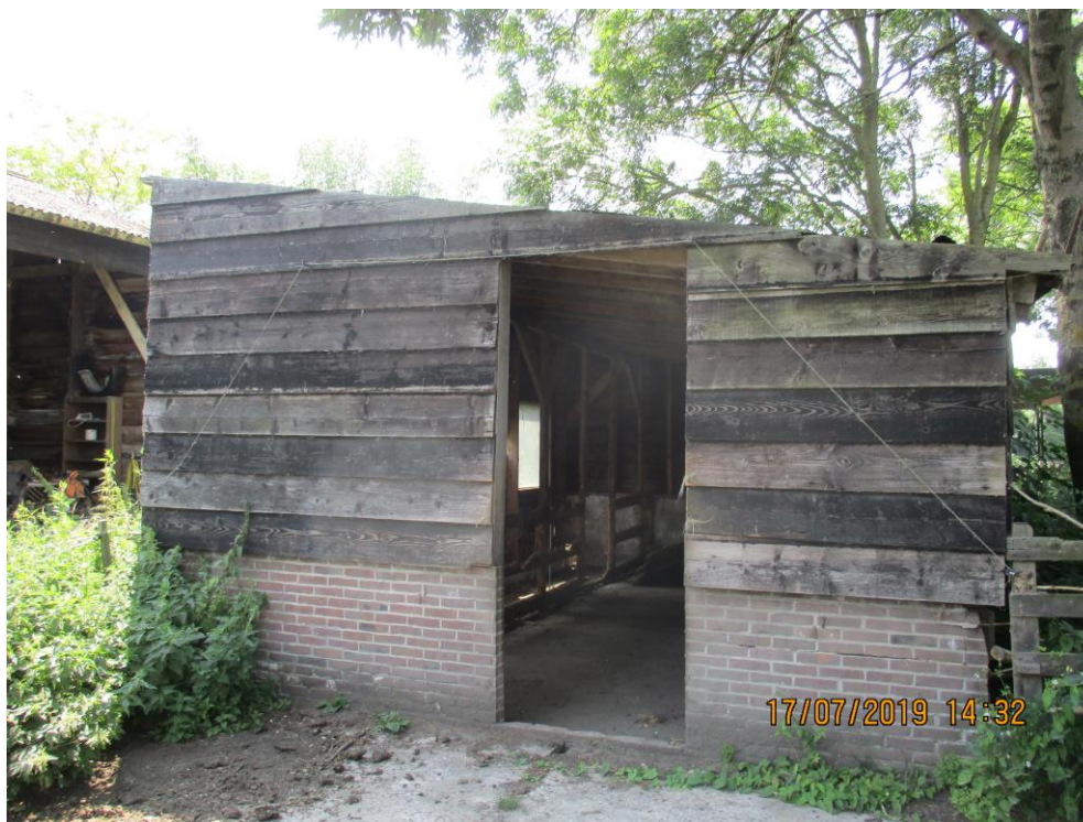
Figuur 2 Schuur B heeft een laag gemetselde muur van ongeveer 75 cm met daarboven enkel laags hout met een plasticfolie dak.
