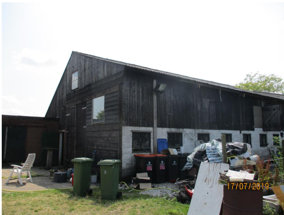
Figuur 1 De planlocatie is gelegen aan de Brandwijkse dijk 26/26a te Brandwijk en bestaat uit twee schuren, schuur A heeft een gemetselde muur van ongeveer 2,5 m hoog (zonder spouw), daarboven enkel laags hout met een golfplaten zadeldak.
