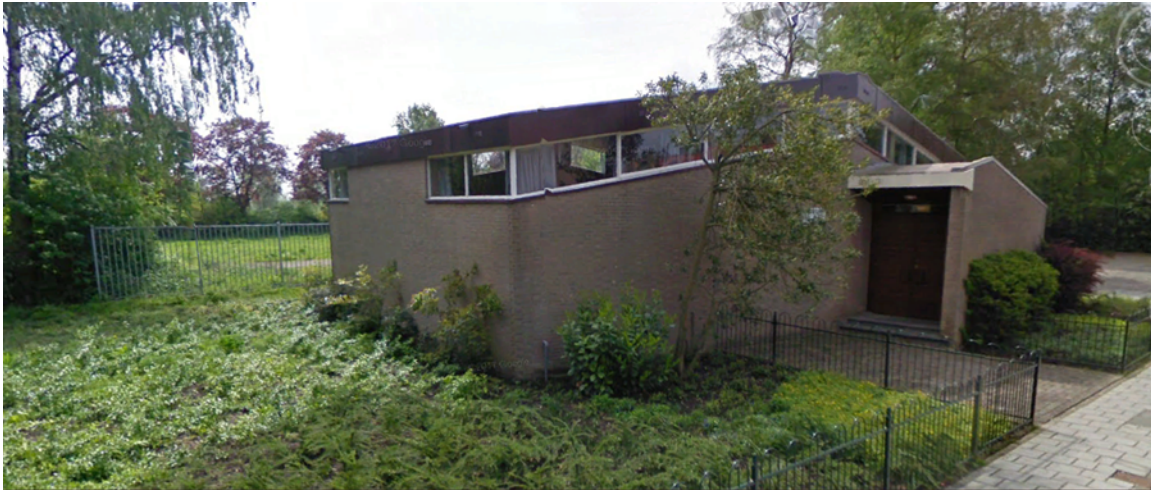
Figuur 2.4: Foto kerkgebouw.
