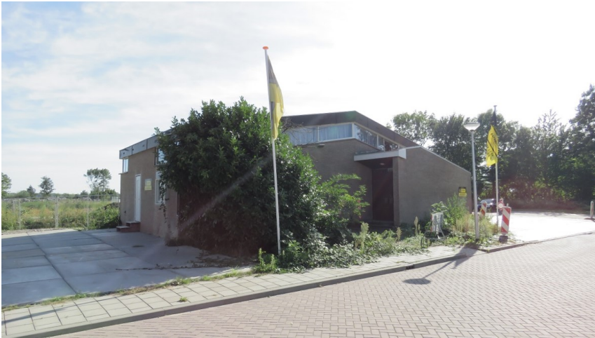
Afbeelding 3: Verwilde beplanting ter plaatse van de entree van de kerk.
