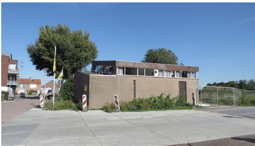
Afbeelding 2: Zicht op de westgevel van het kerkgebouw.
