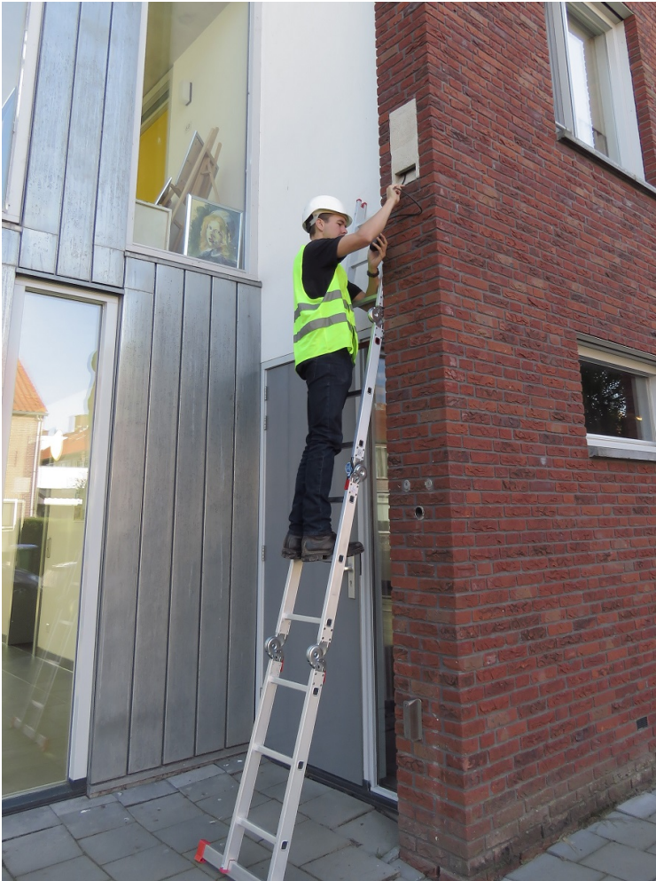
Afbeelding 6: Inspectie van de inbouwstenen aan De Hooghe Boei met een endoscoop camera.
