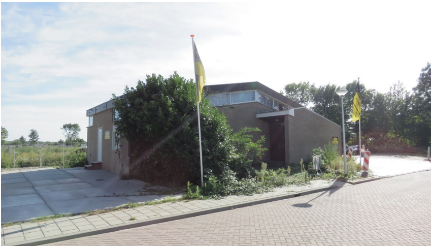
Afbeelding 3: Verwilderde beplanting ter plaatse van de entree van de kerk.
