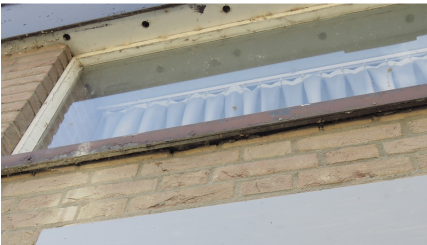
Afbeelding 10: Onder de raamkozijnen bevinden zich kieren waar dwergvleermuizen gebruik van zoude kunnen maken.
