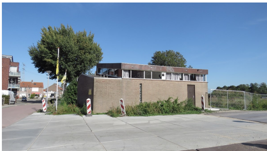
Afbeelding 2: Zicht op de westgevel van het kerkgebouw.
