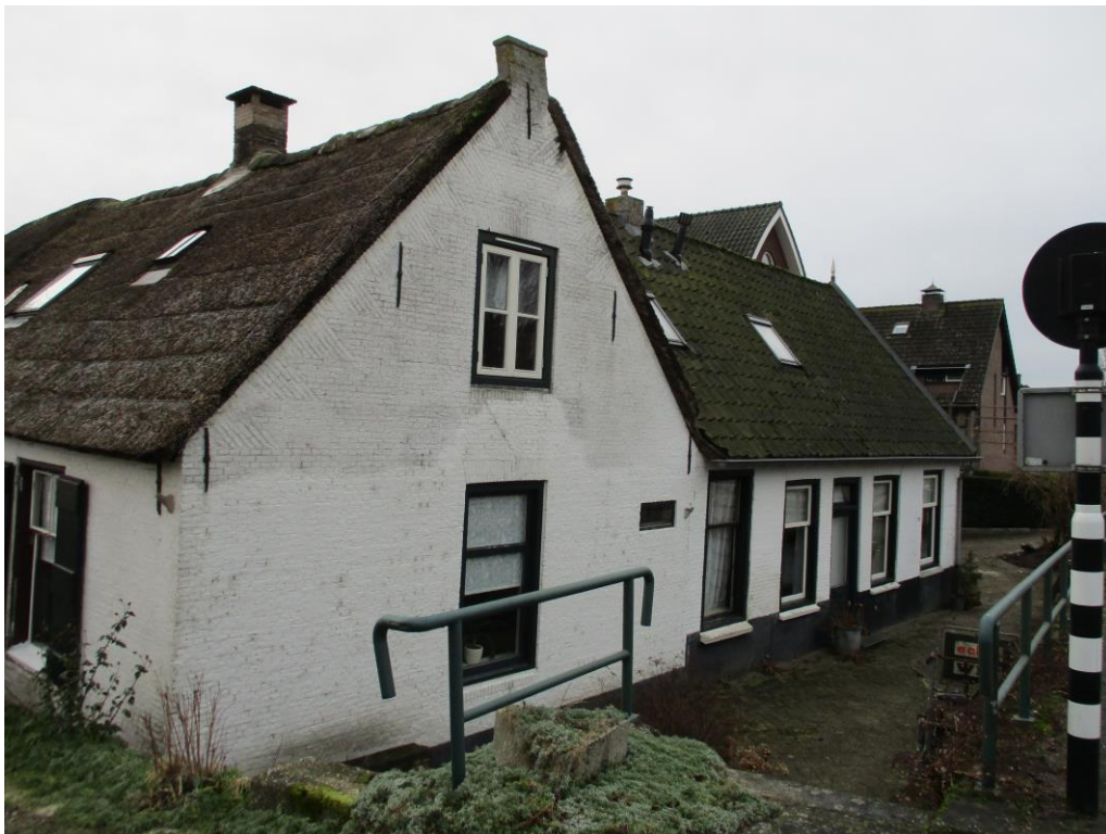
Figuur 1 De planlocatie is gelegen aan de B 4 te Ottoland en het betreft een woning opgetrokken uit gemetselde muren zonder spouw en zadeldak enerzijds met riet (oostzijde), anderzijds met dakpannen (westzijde).
