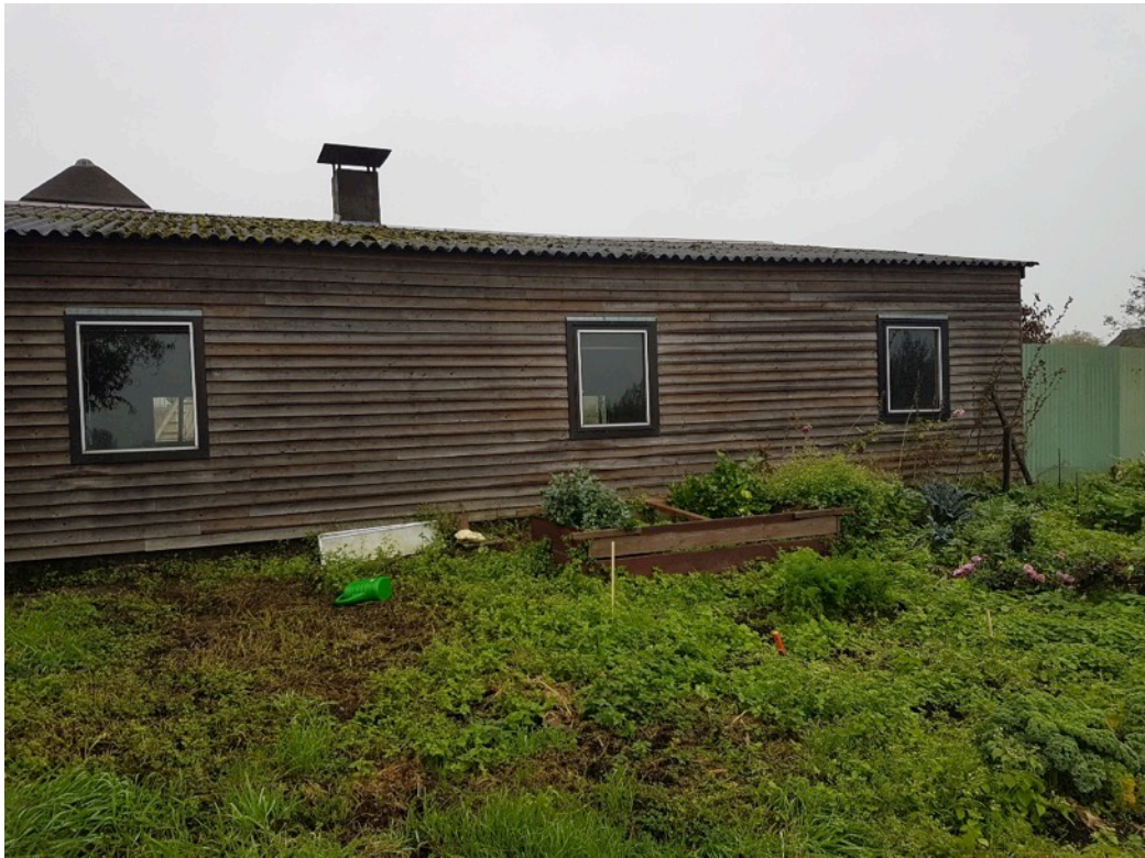
Figuur 5 Jongveestal en aanliggende moestuin.
