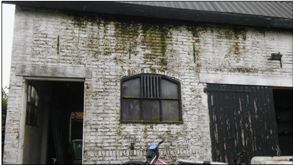
Figuur 3 De schuur is opgetrokken uit gemetselde muren en heeft een schuin golfplaten dak.
