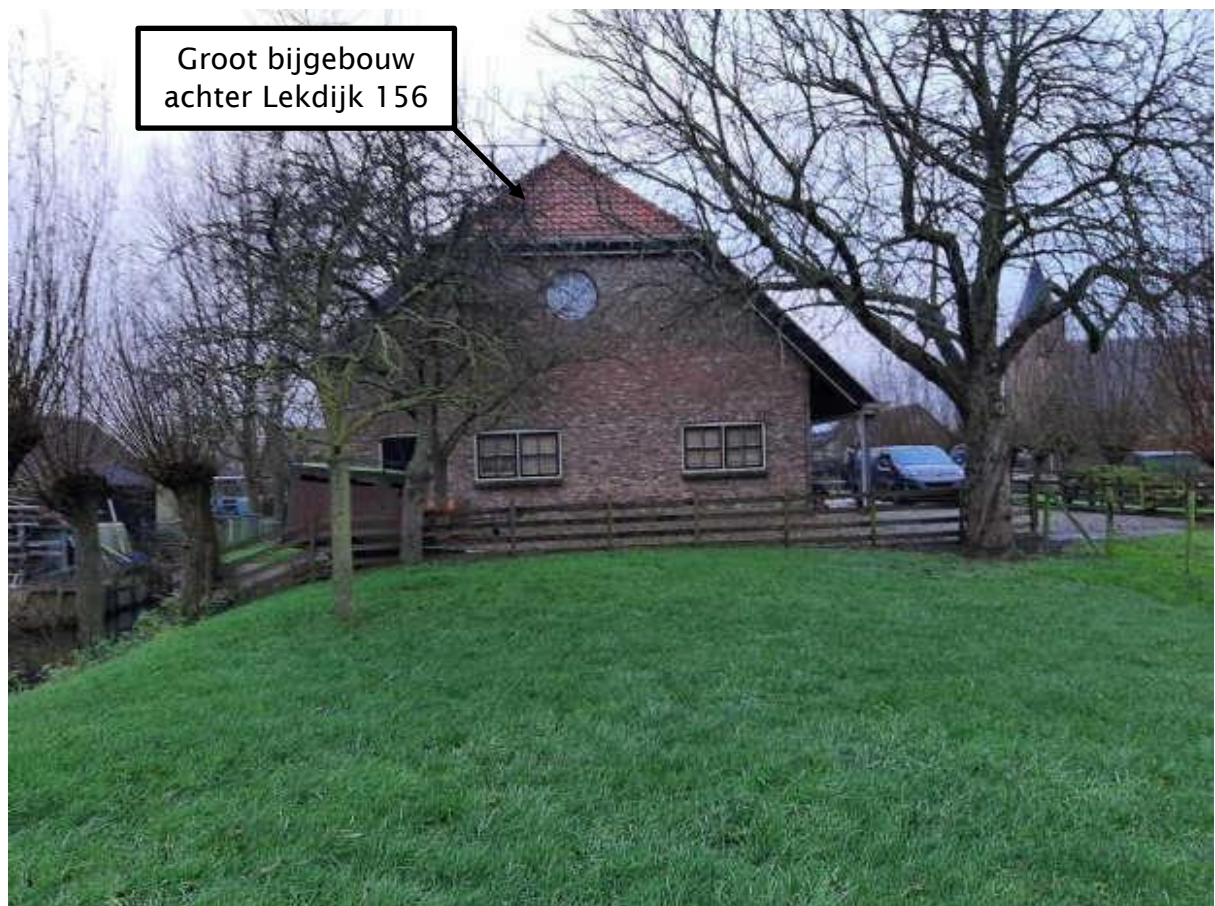
Afbeelding 4: Zicht op de achterkant van het gebouw achter Lekdijk 156
