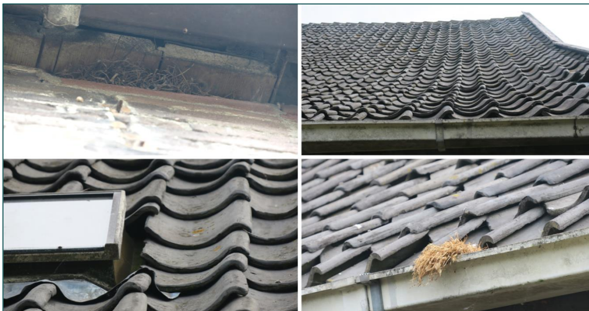
Figuur 3.3 Links boven: nestmateriaal tussen de gevel en het dakbeschot van de woning. Overige foto's: De ruimten tussen de dakpannen in de woning en aaneengesloten schuren (2) bieden mogelijk geschikte nestlocaties voor de huismus.
