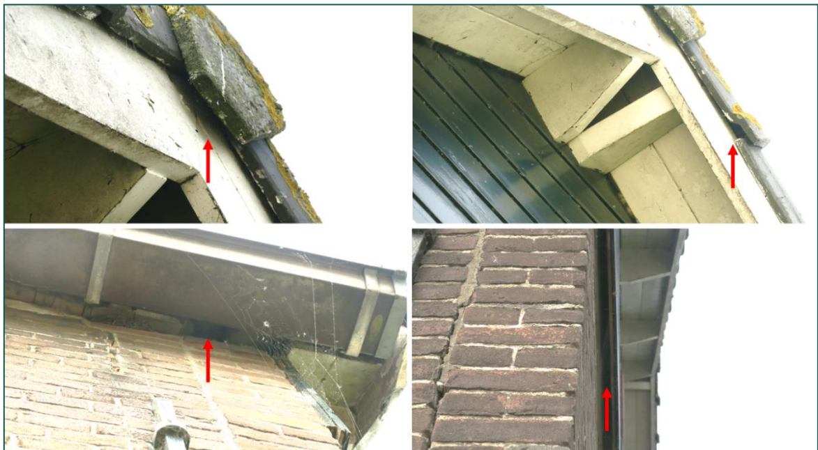
Figuur 3.1 De open dakruimte van de woning is voor vleermuizen toegankelijk via meerdere openingen. Tevens is er een voor vleermuizen geschikte ruimte beschikbaar achter de houten schroten aan de voorgevel.
