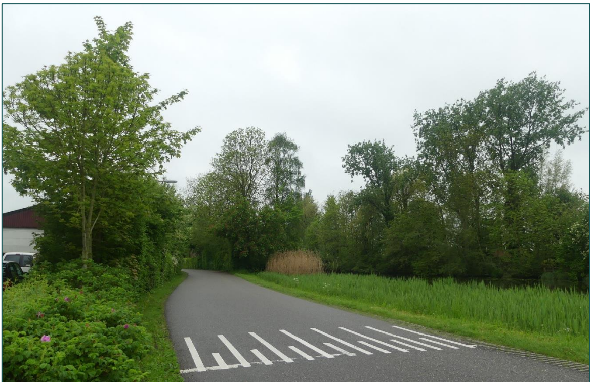
Figuur 4 Zicht op de doorgaande weg, grenzend aan de noordzijde van het perceel.
