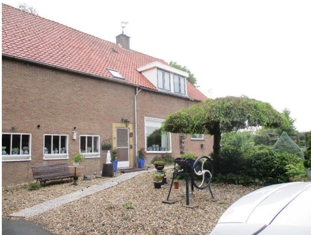
Figuur 1 De twee woningen (A) (twee onder één kap) op de planlocatie is gelegen aan de Abbekesdoel 45 en 46 te Bleskensgraaf.
