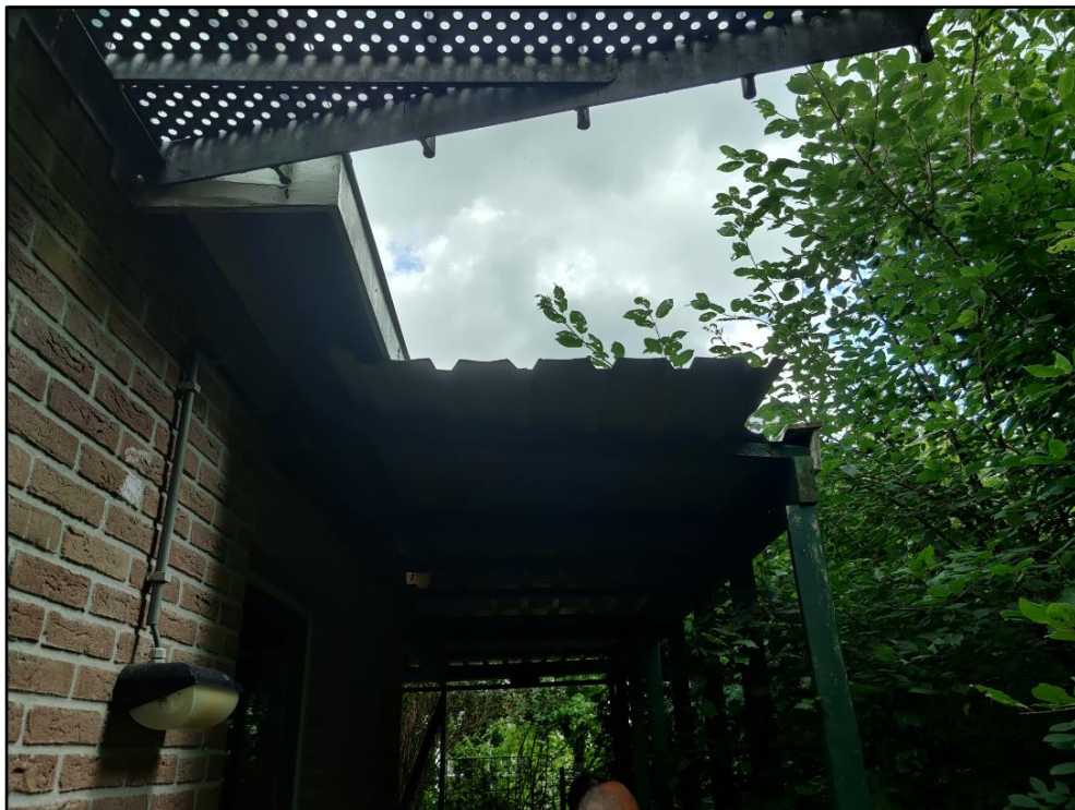
Figuur 3 Aan de achterzijde van de bebouwing op Abbekesdoel 34a versperren een dakconstructie en de groenstructuren de aanoliegroute voor vleermuizen naar de spouwmuur.
