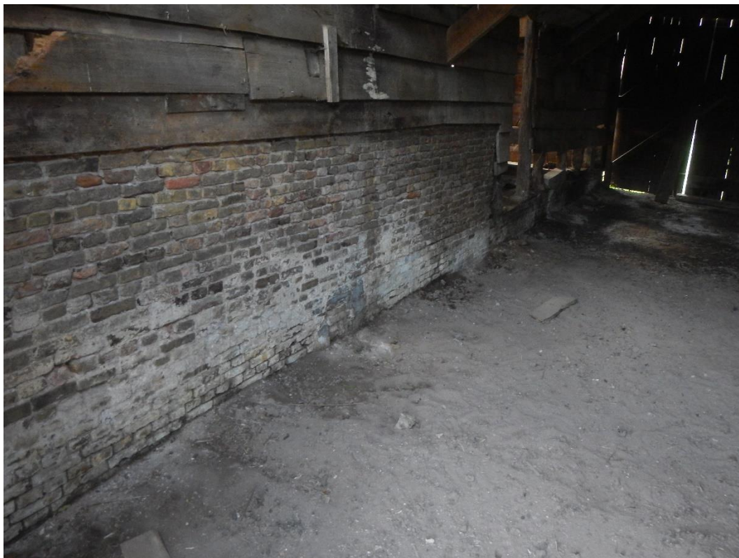
Figuur 8: Goed bewaard deel van de oorspronkelijke westelijke buitenmuur.
