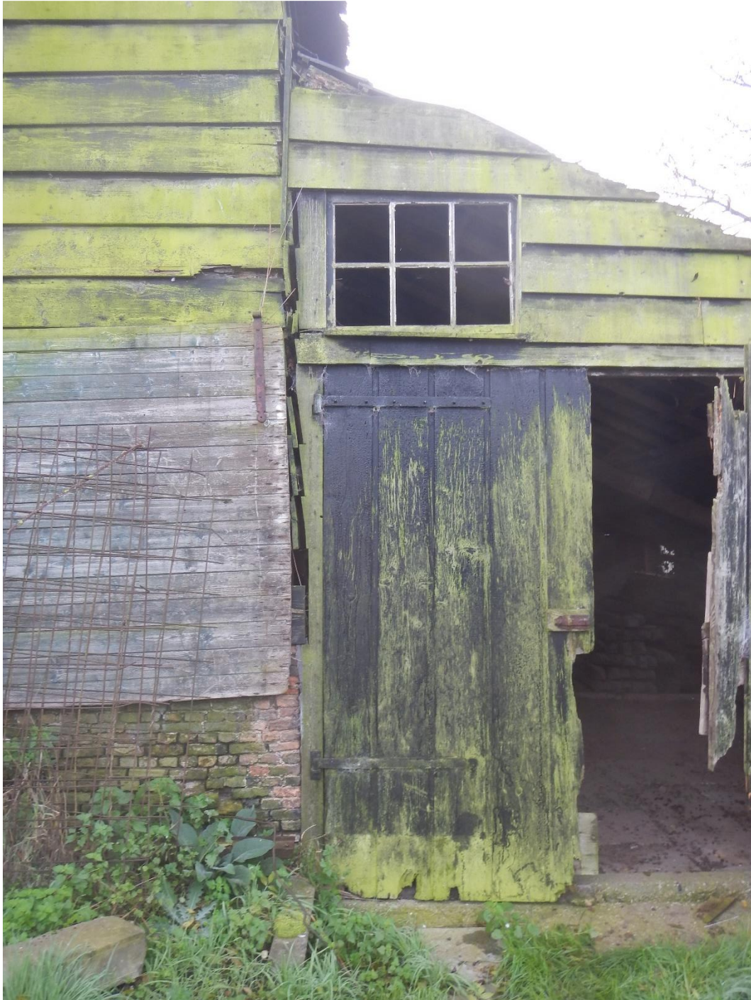
Figuur 7: Het westelijke gedeelte van de stal is voorzien van een lessenaarsdak en een fundering van betonbalken. Deze uitbreiding is duidelijk tegen het oudere oostelijke stalgedeelte aangezet.
