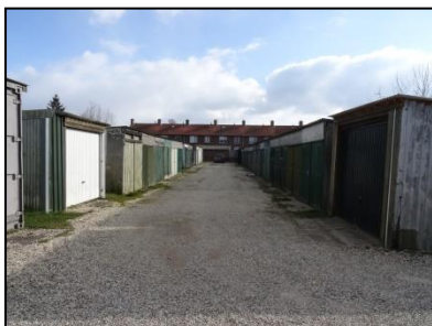
Figuur 6. Zicht op garages (oostelijke deel van de onderzoekslocatie).
