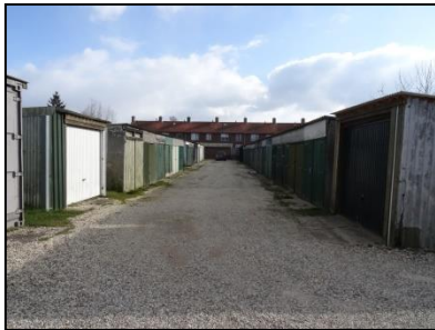
Figuur 6. Zicht op garages (oostelijk deel van de onderzoekslocatie).
