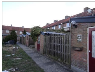
Figuur 4. Zicht op duplexwoningen, achtertuinen en schuurtjes.
