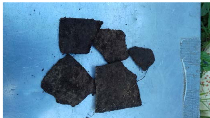
foto 08 - inspectiegat IG107 [stukjes plaat]
