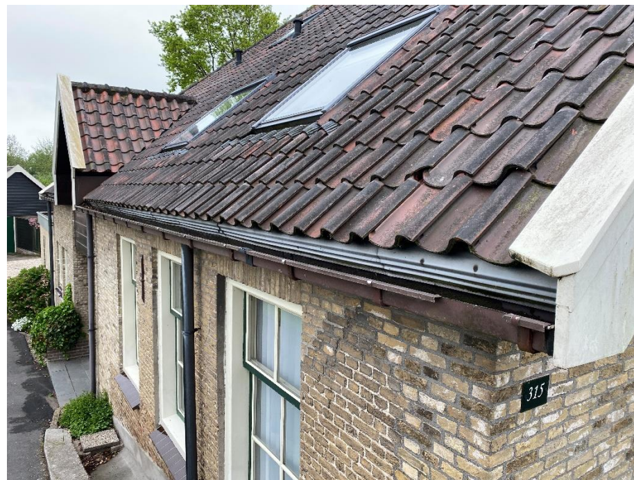
Figuur 20. Het geschikt maken van het dak van woning nummer 315 voor huismussen is een geschikte methode om het verlies aan verblijfplaatsen in woning 307 op te vangen.
