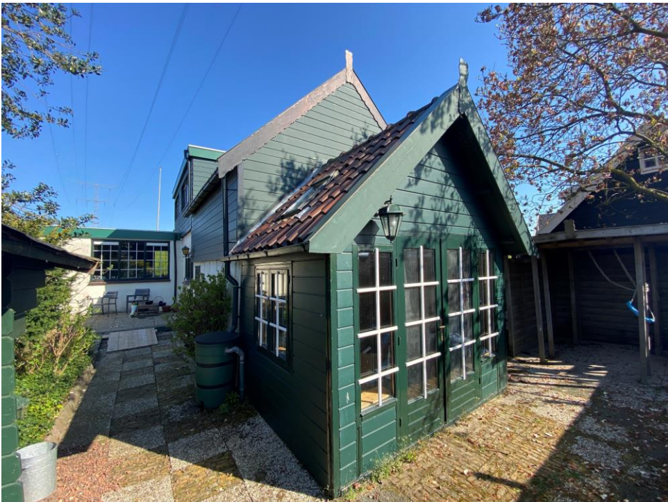
Figuur 8. Beeld van woning 307 (achterzijde, zuidzijde).
