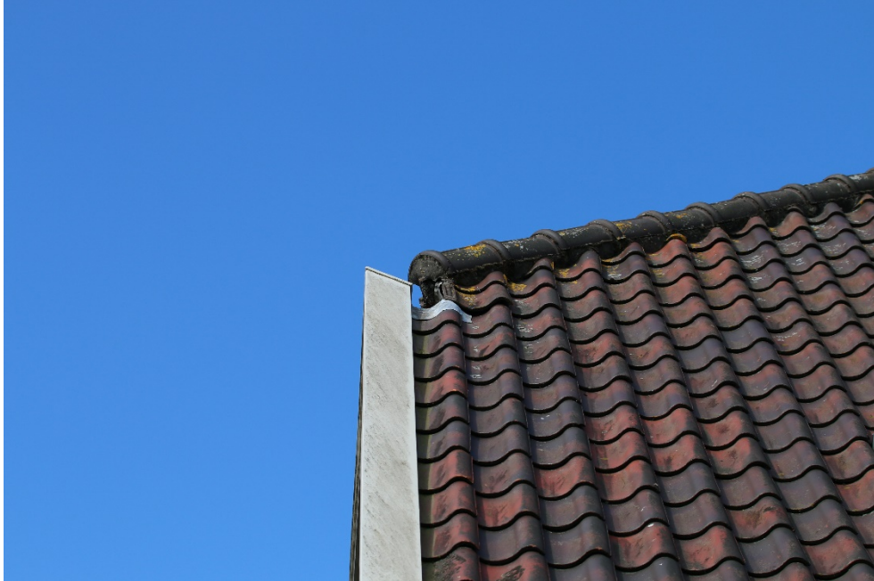
Figuur 31. Indien de hoekopeningen van het dak voldoende ruimte bieden dan zouden deze mogelijk gebruikt kunnen worden door soorten als steenuil of gierwaluw.
