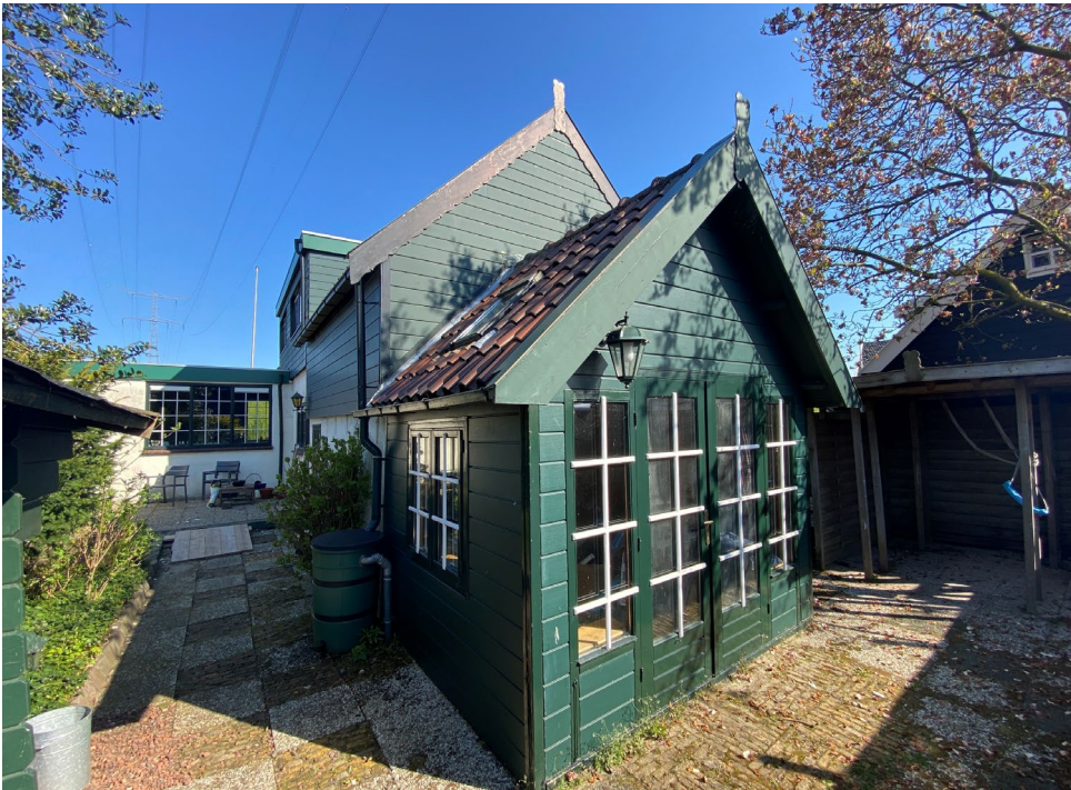
Figuur 8. Beeld van woning 307 (achterzijde, zuidzijde).
