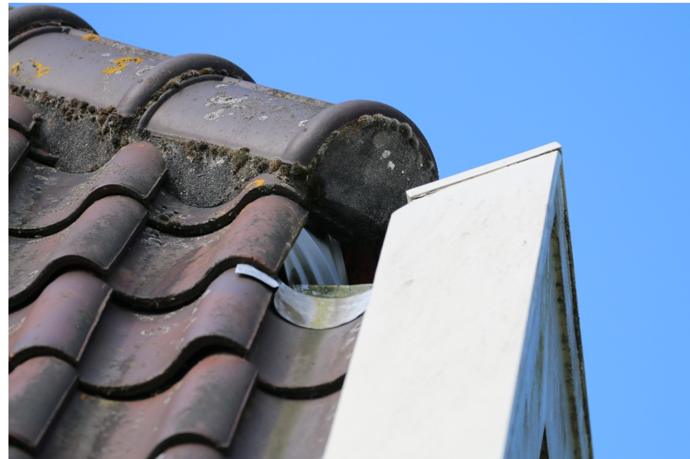
Figuur 32. De openingen op de hoekpunten van het dak van nummer 315 lijken te zijn afgesloten.
