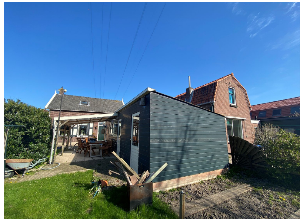
Figuur 6. Beeld van woning 312 (achterzijde, zuidzijde)
