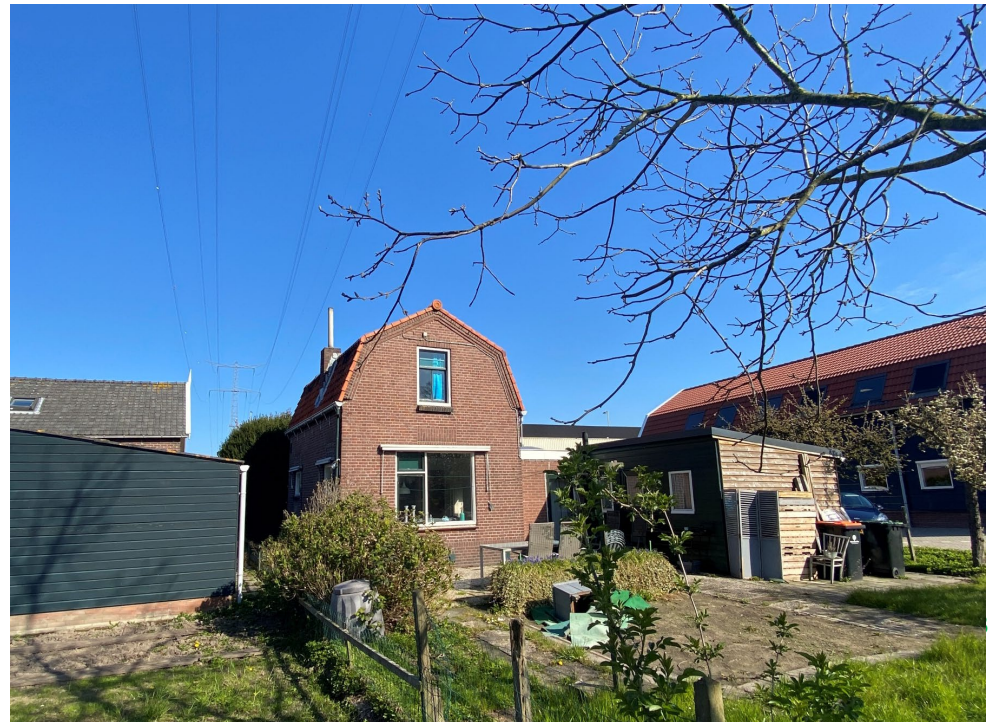
Figuur 10. Beeld van woning 314 (achterzijde, zuidzijde)
