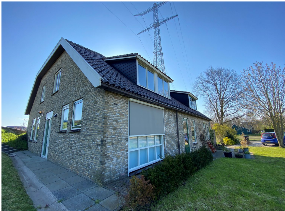
Figuur 4. Beeld van woning 315 (achterzijde, zuidwestzijde).
