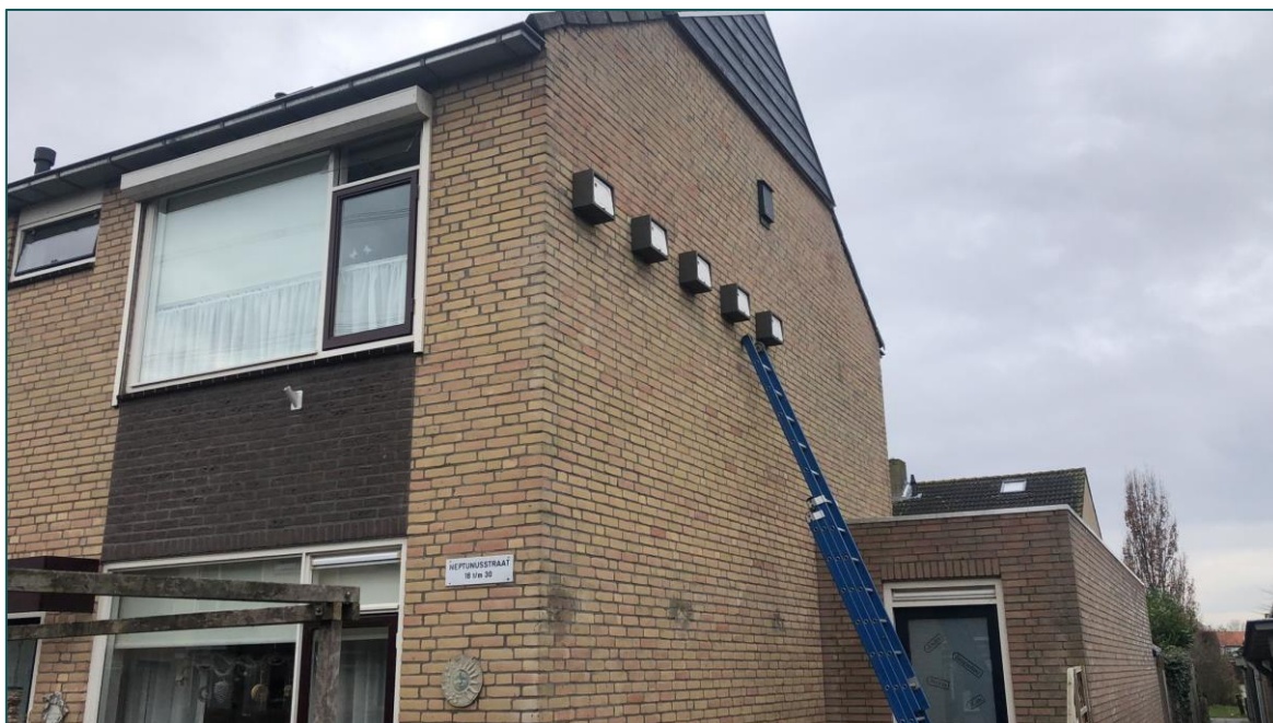
Figuur 3.2 Voorbeeld van geplaatste tijdelijke huismuskasten en een vleermuis kast aan een kopgevel in de Neptunusstraat.
