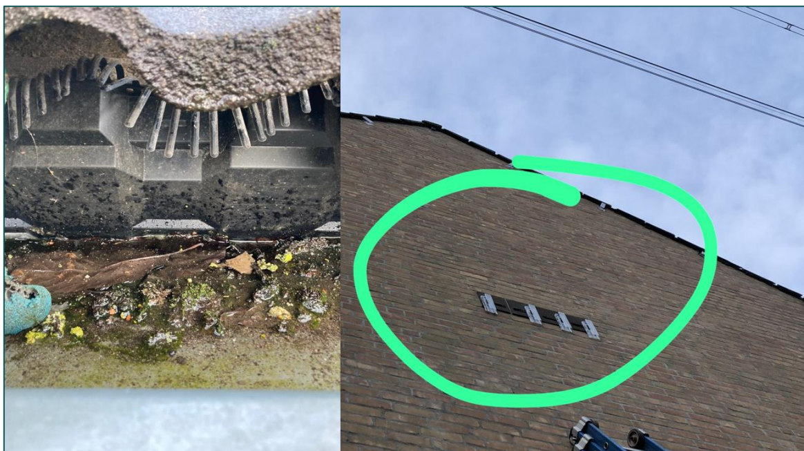
Figuur 3.1 Wijze van ongeschikt maken. Links: het ontoegankelijk maken van nestlocaties van de huismus. Rechts: door middel van exclusion flaps zijn vleermuisverblijfplaatsen ontoegankelijk gemaakt.
