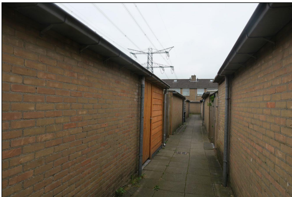
Figuur 2 De schuurtjes aan de achterzijde van de woningen aan de Venuslaan.
