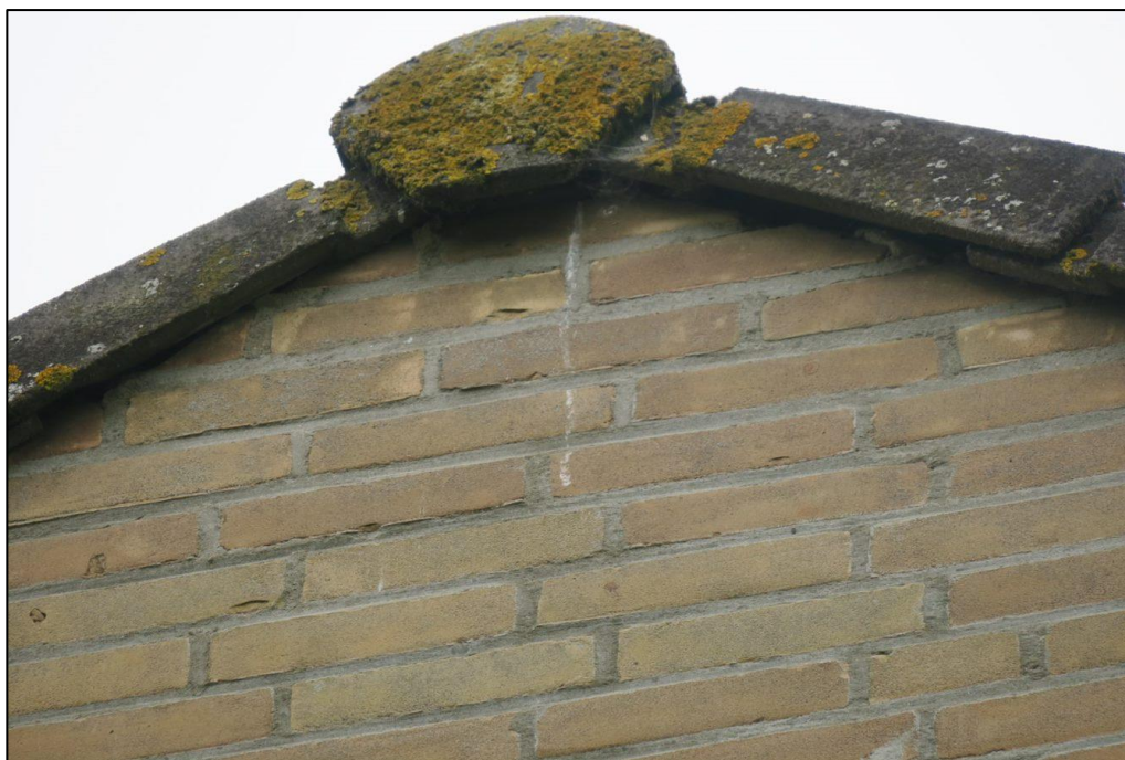
Figuur 8 Een kierende nokpan waaronder krijtsporen zijn waargenomen.
