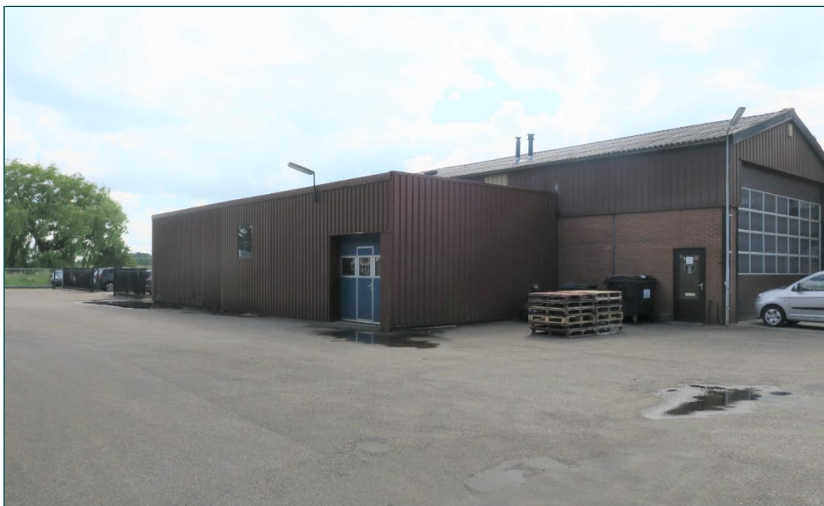
Figuur 2 De te slopen garage.
