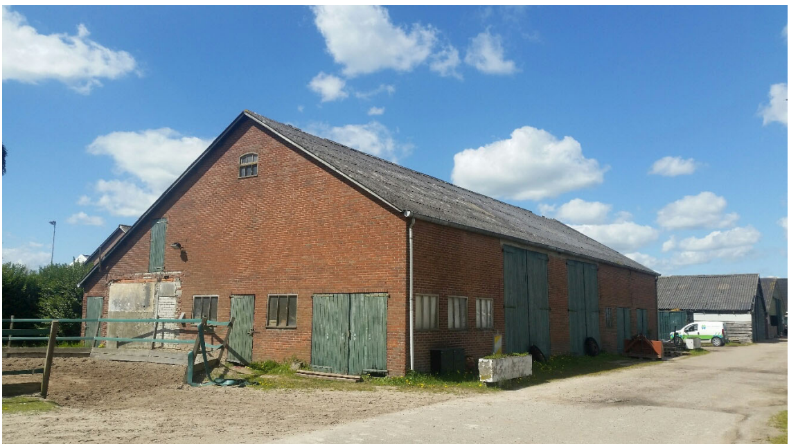
Foto De te slopen bakstenen opslagloods
