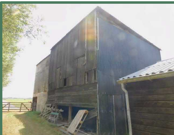
Houten wand slootzijde te slopen stal
