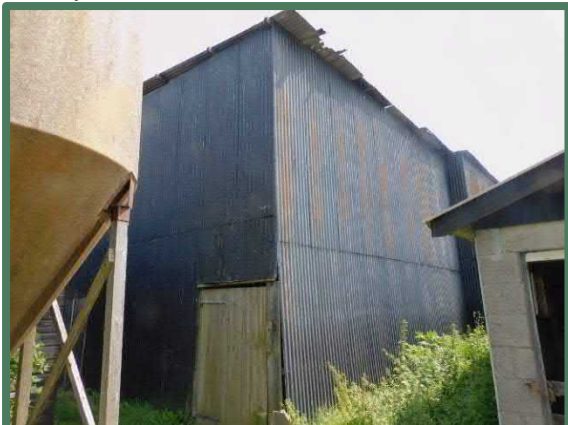
Golfplaten wand te slopen stal
