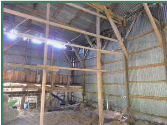
Binnenzijde te slopen stal
