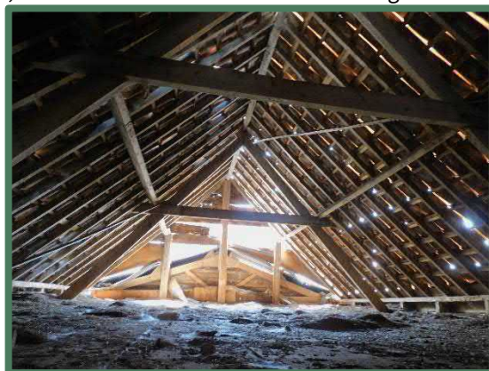
Onderzijde niet-geïsoleerde dak houten stal
