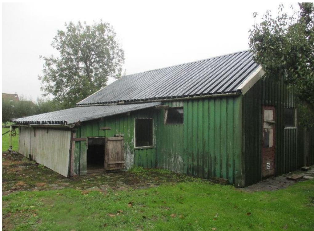
Figuur 2 De voorste schuur (A) is opgetrokken uit metalen damwandplaten. Er is een dakgoot aanwezig. Aan de noordzijde is een uitbouw in de vorm van een klein schuurtje, ook hier is een dakgoot aanwezig.
