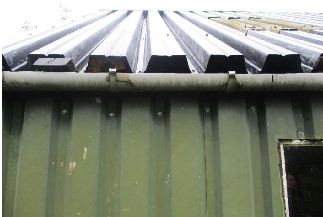
Figuur 3 Het dak van de voorste schuur bestaat uit geprofileerde metaalplaten die aan de onderkant grotendeels zijn dichtgepurd.
