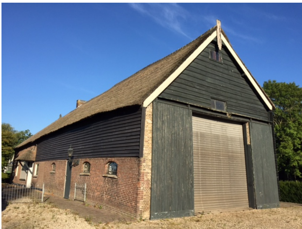
Figuur 2 De schuur bestaat uit stenen muren met potdekselplanken. Aan de oostzijde is een grote roldeur aanwezig.
