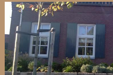
Metselwerklagen en staande kozijnen
